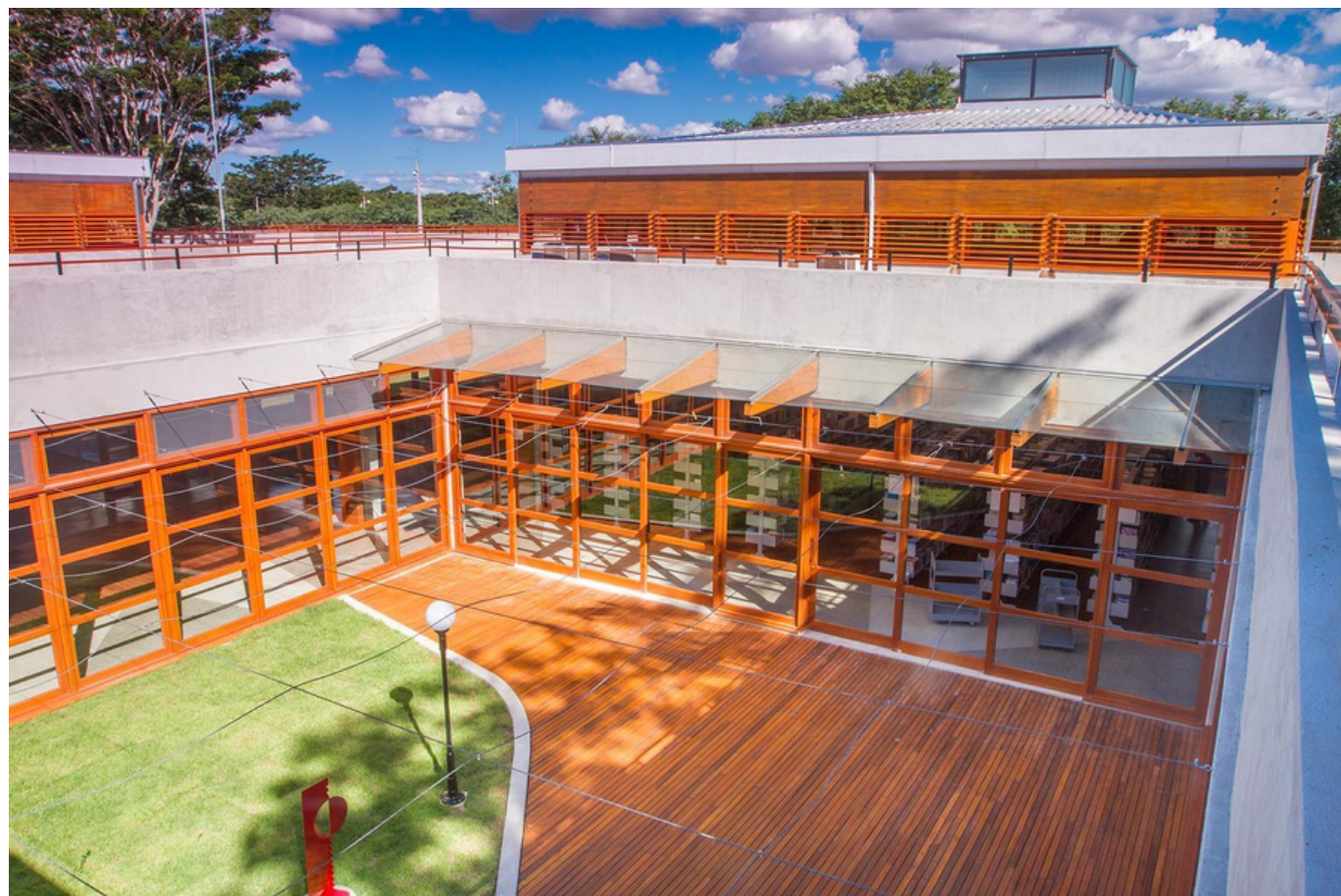
Figura 53 - Estrutura em MLC Biblioteca Paulo Freire Fonte: Vieira (2022)
