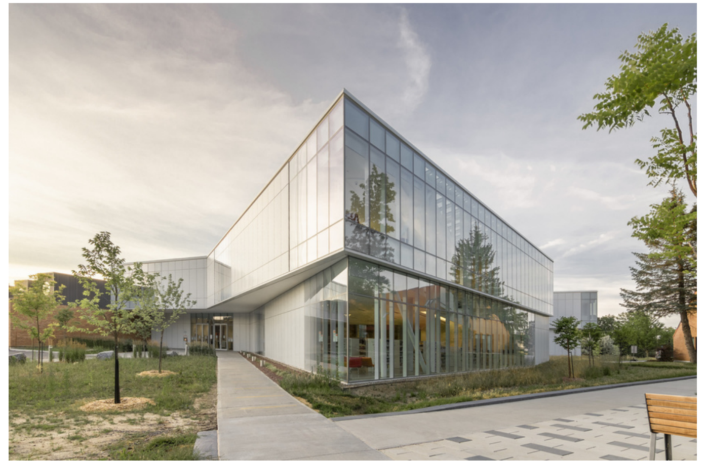
Figura 42 - Laje em balanço e Cortinas envidraçadas Biblioteca Pública Pierrefonds Fonte: archdaily.com (2022)
