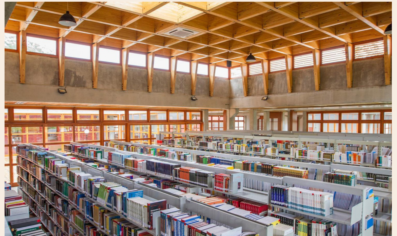
Figura 59 - Estrutura em MLC Biblioteca Paulo Freire Fonte: Vieira (2022)
