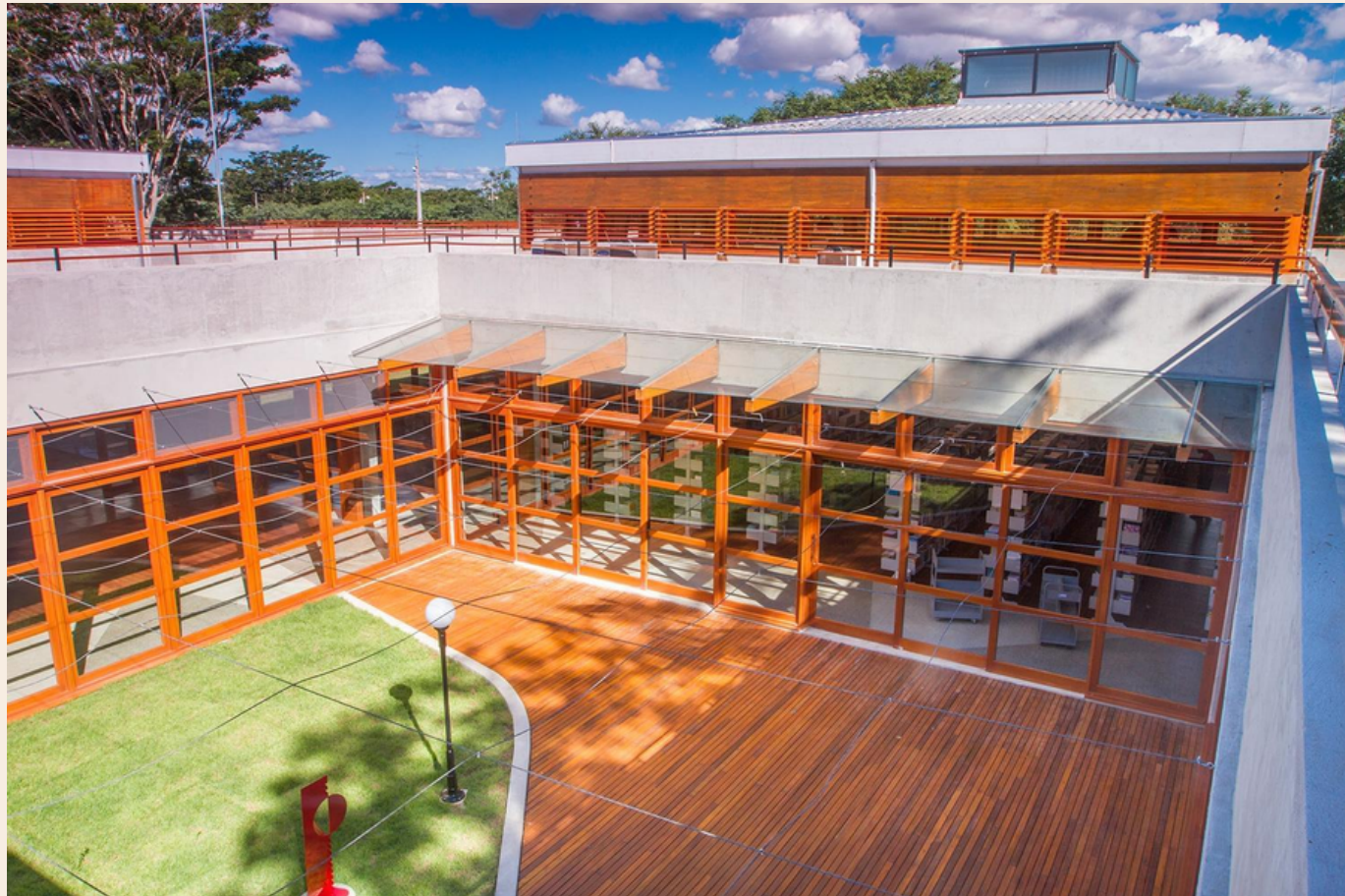
Figura 58 - Estrutura em MLC Biblioteca Paulo Freire Fonte: Vieira (2022)
