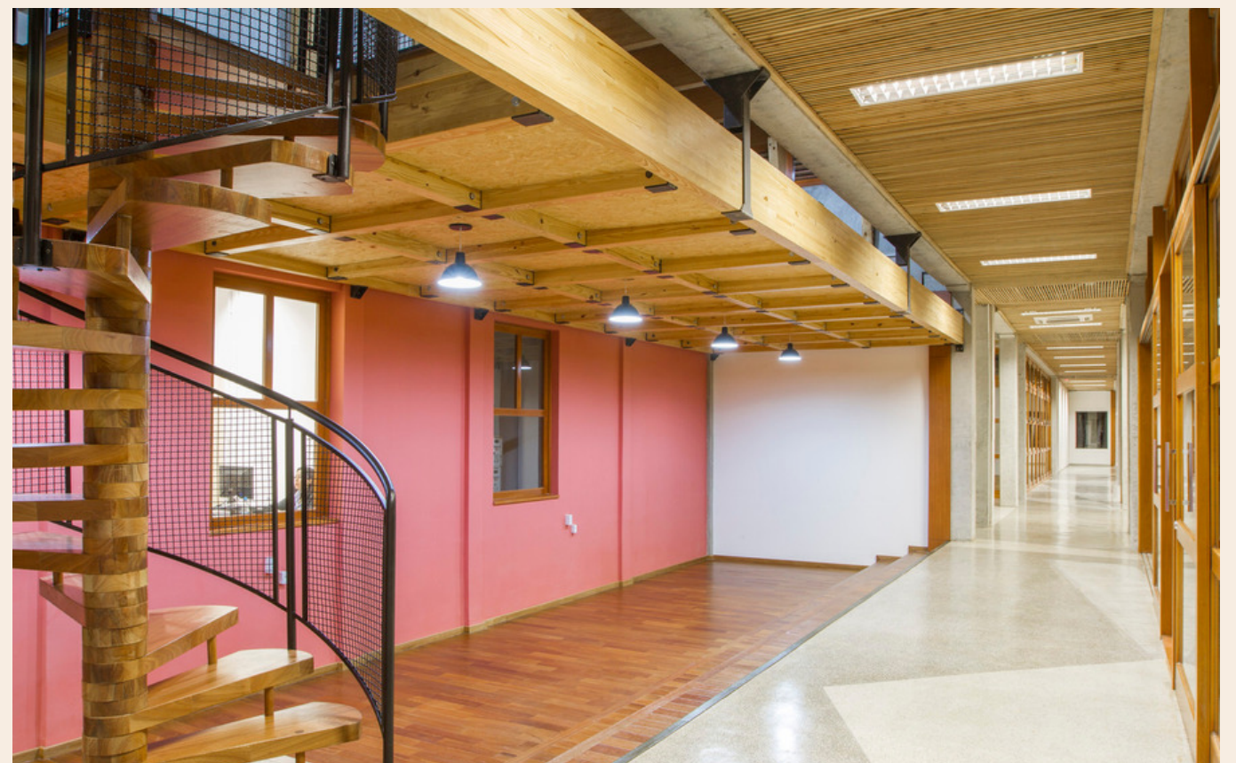
Figura 60 - Estrutura em MLC Biblioteca Paulo Freire Fonte: archdaily.com (2014)
