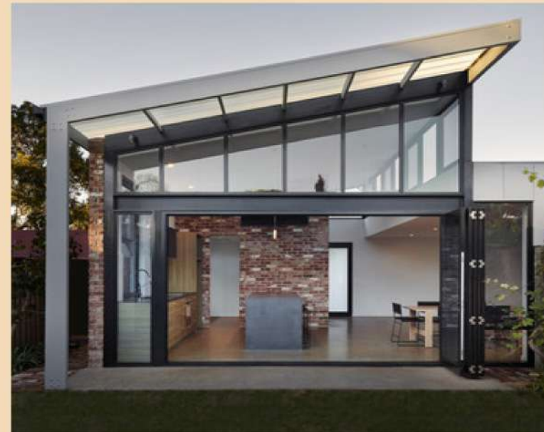
POLICARBONATO TRANSLÚCIDO (IMAGEM: Archdaily)
