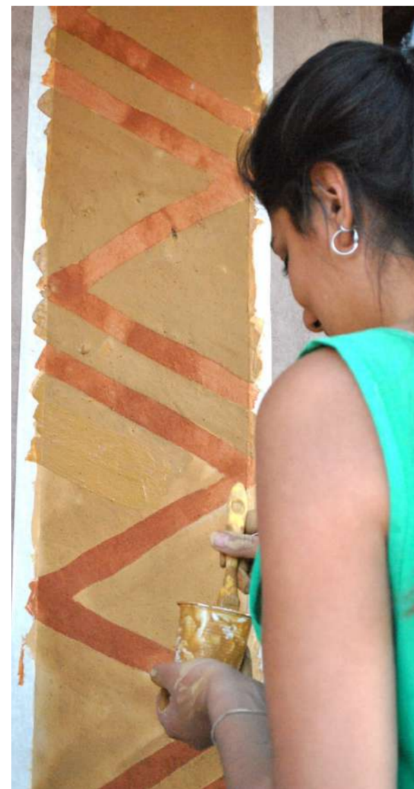
Figura 67 - Pintura em parede durante oficina
