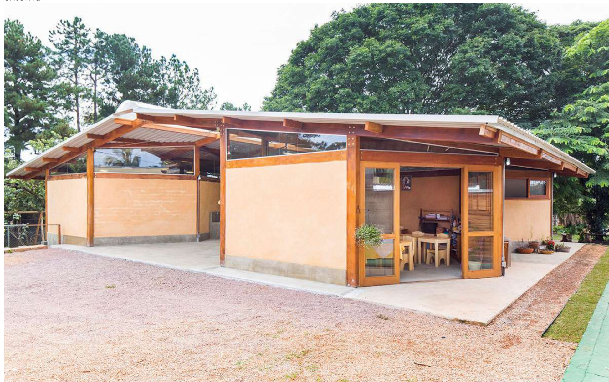
Figura 69— Escola Ecoara vista externa
