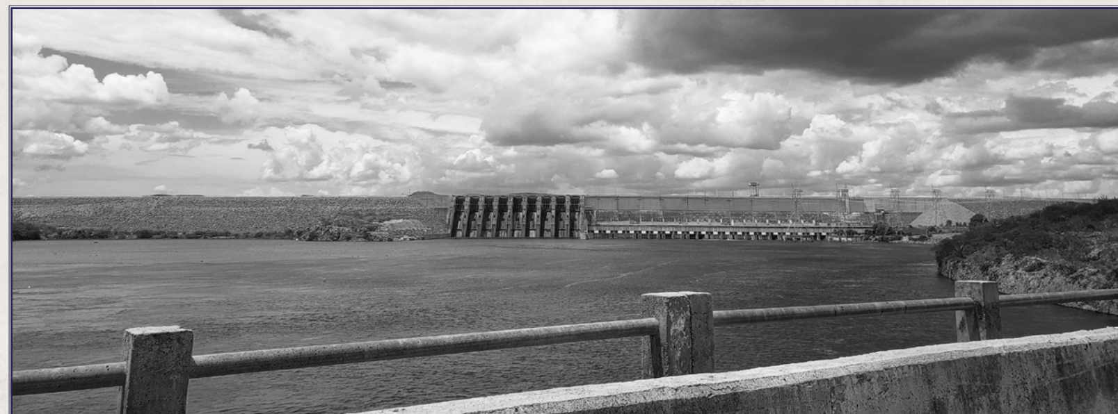
1. Usina Hidroelétrica de Itaparica/ Luiz Gonzaga
