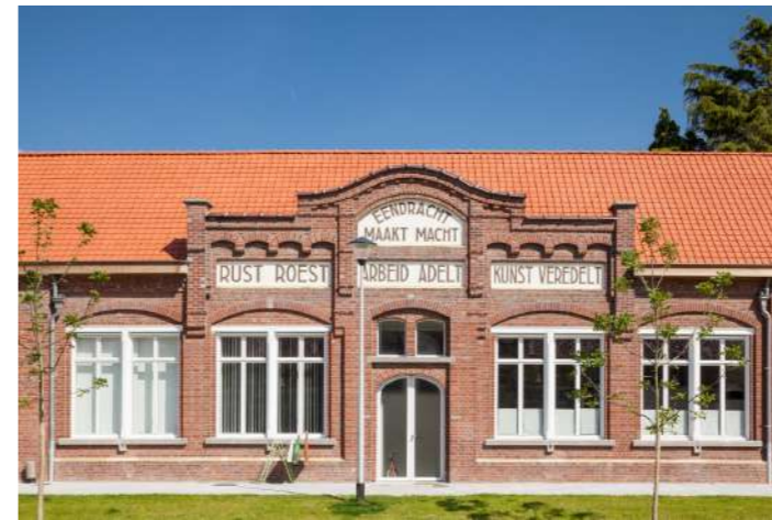
Fachada da antiga escola, restaurada e mantida intacta
