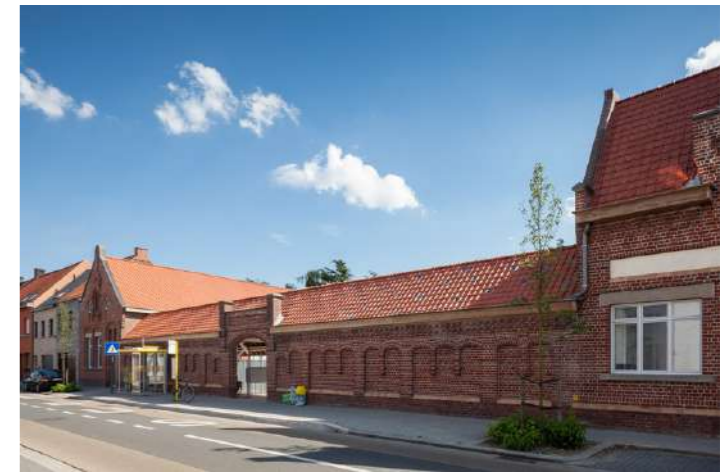
Fachada da antiga escola, restaurada e mantida intacta
