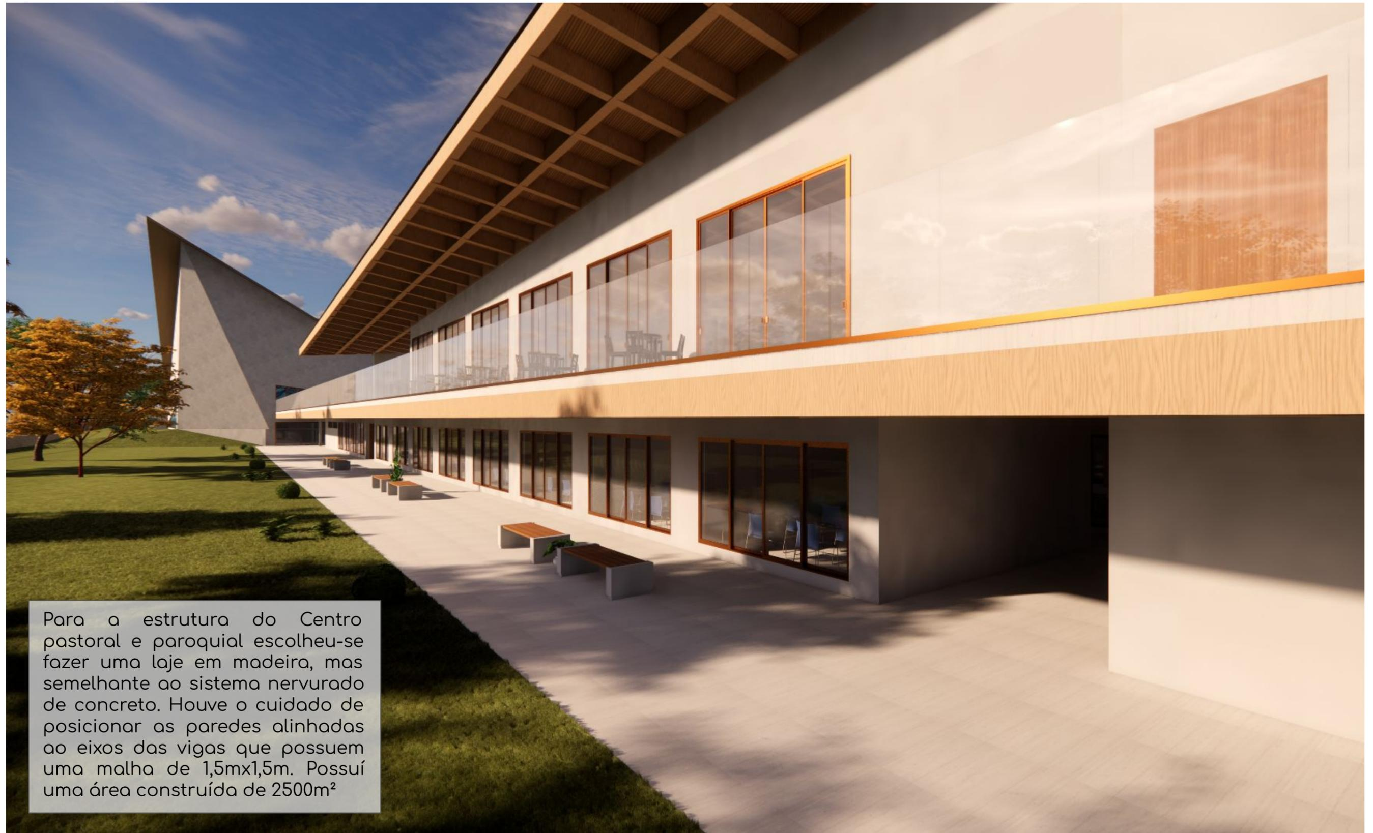
Para a estrutura do Centro pastoral e paroquial escolheu-se fazer uma laje em madeira, mas semelhante ao sistema nervurado de concreto. Houve o cuidado de posicionar as paredes alinhadas ao eixos das vigas que possuem uma malha de 1,5mx1,5m. Possui uma área construída de 2500m<sup>2</sup>
