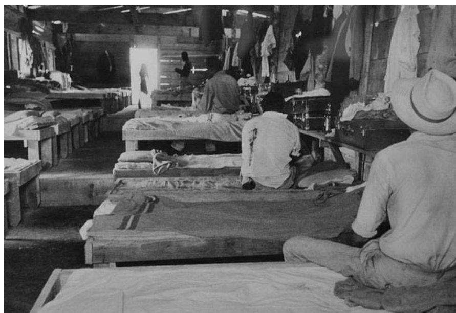
Barracões de trabalhadores durante a construção de Brasília. Arquivo Público do Distrito Federal ARPDF
