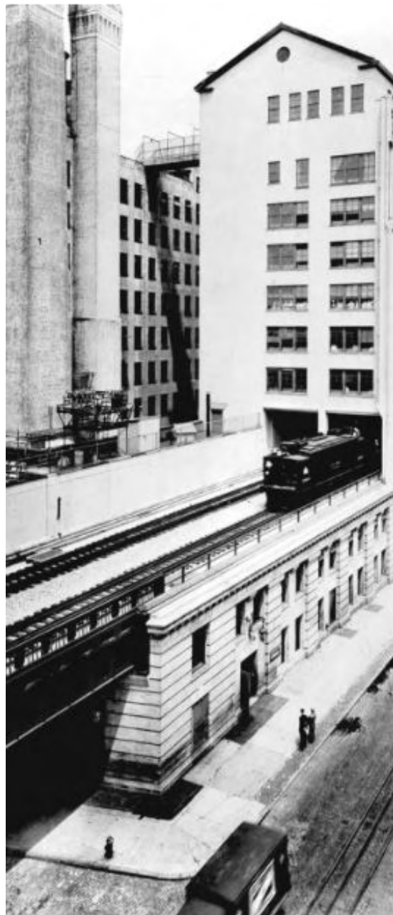
Com o High Line em funcionamento, edifícios adaptaram suas estruturas para abrigar os trens ferroviários. Fonte: The High line website.
