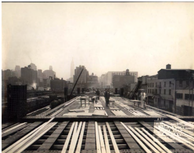
High Line em construção. Fonte: The High line website.
