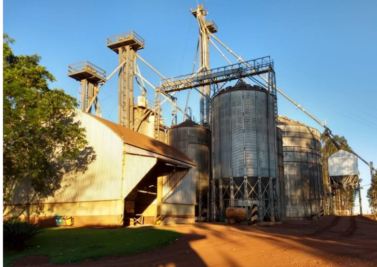
Imagem 02: Silo e moega – Fazenda Cachoeira
