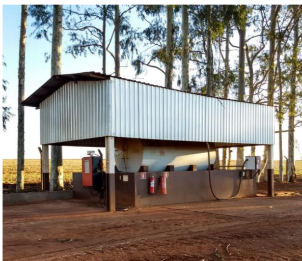
Imagem 01: Tanque de diesel – Fazenda Cachoeira
