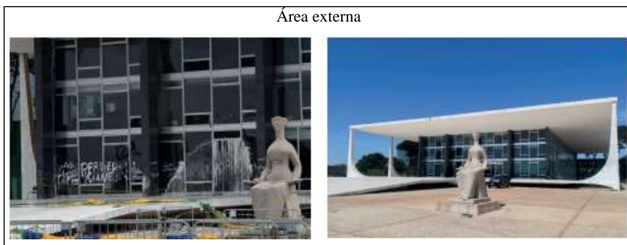
Figura 14 - Área externa destruída / Figura 15 - Área externa recuperada após os ataques
