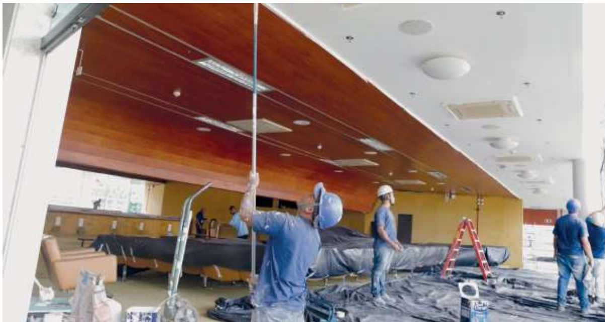
Figura 16 - Plenário sendo restaurado
