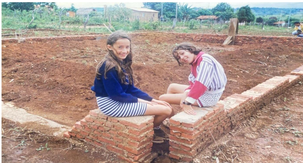
Figura A- 20: Clara e Helena na construção do galpão do boi
