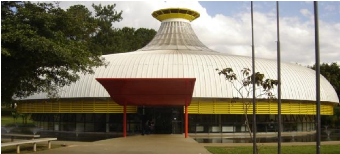
Figura 4.1 - Visão do prédio do Beijódromo.
