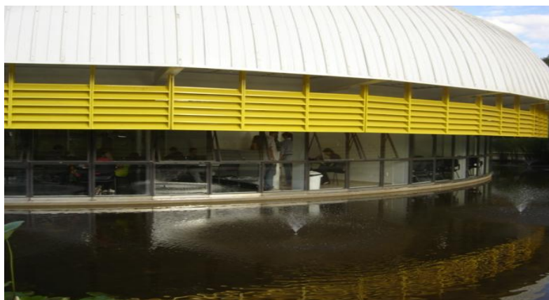
Figura 4.10 - Brises de proteção solar do prédio do Beijódromo.
