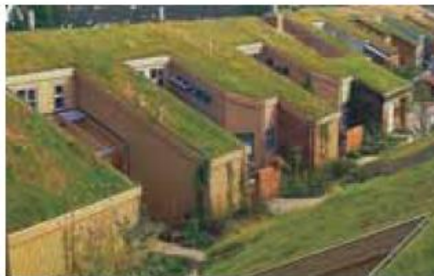
Figura 3.2 - Exemplo de telhado vegetado na Alemanha.
