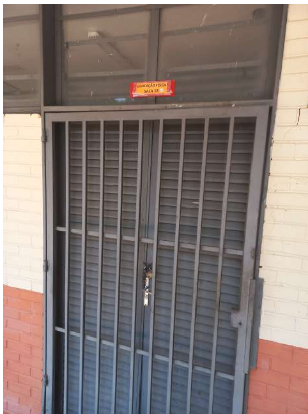
Figura I.10: Registro da Fachada que Dá Acesso ao Espaço Anteriormente Utilizado como Laboratório de Informática e Posteriormente Adaptado para Sala de Educação Física, em 2024. Fonte: o autor.
