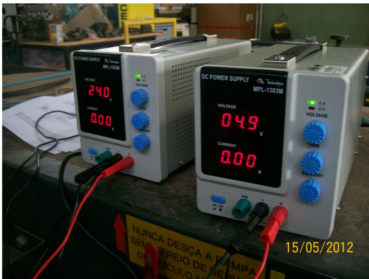
Figura 6.9 – Fonte de acionamento e controle da válvula.
