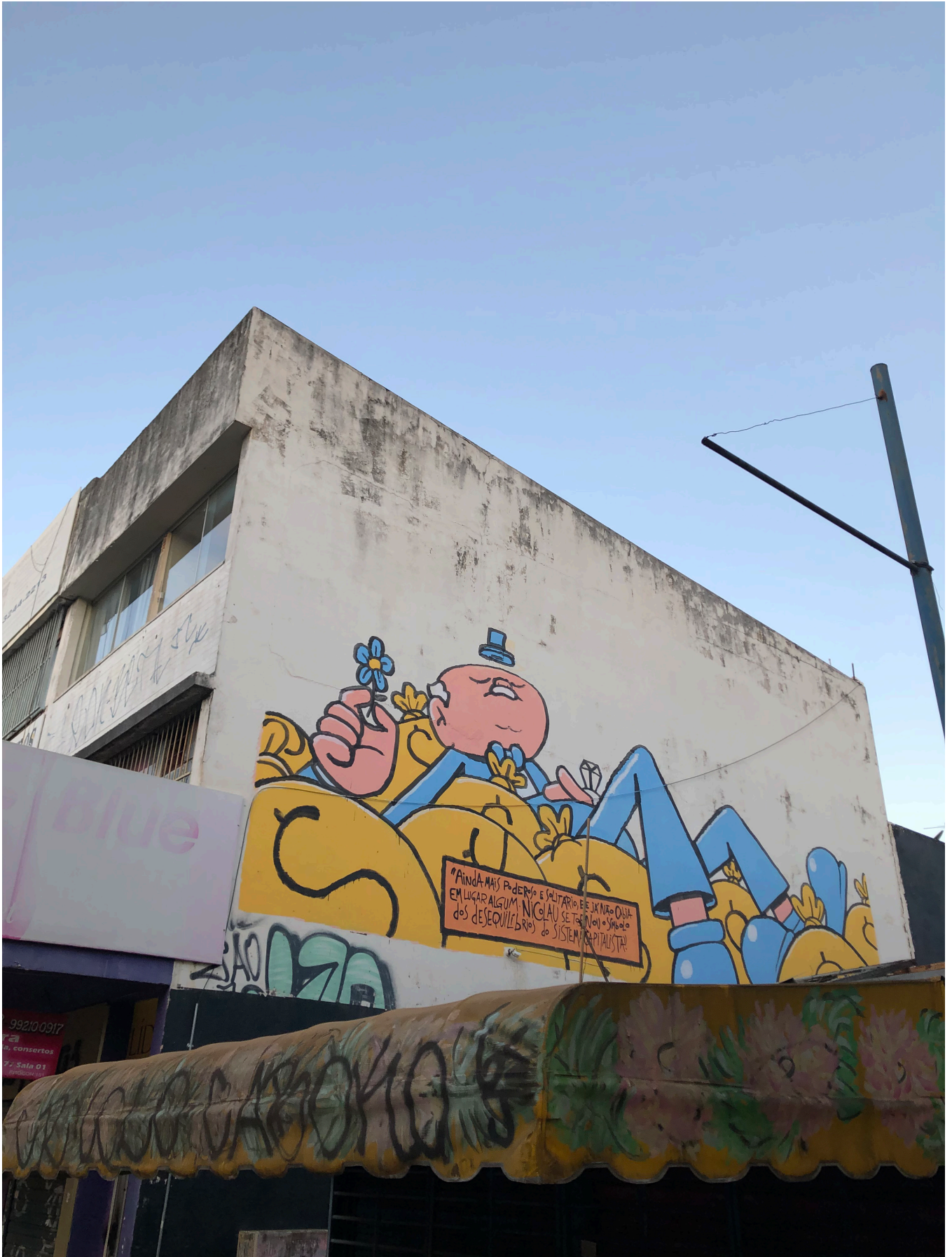
Registro da obra finalizada.
