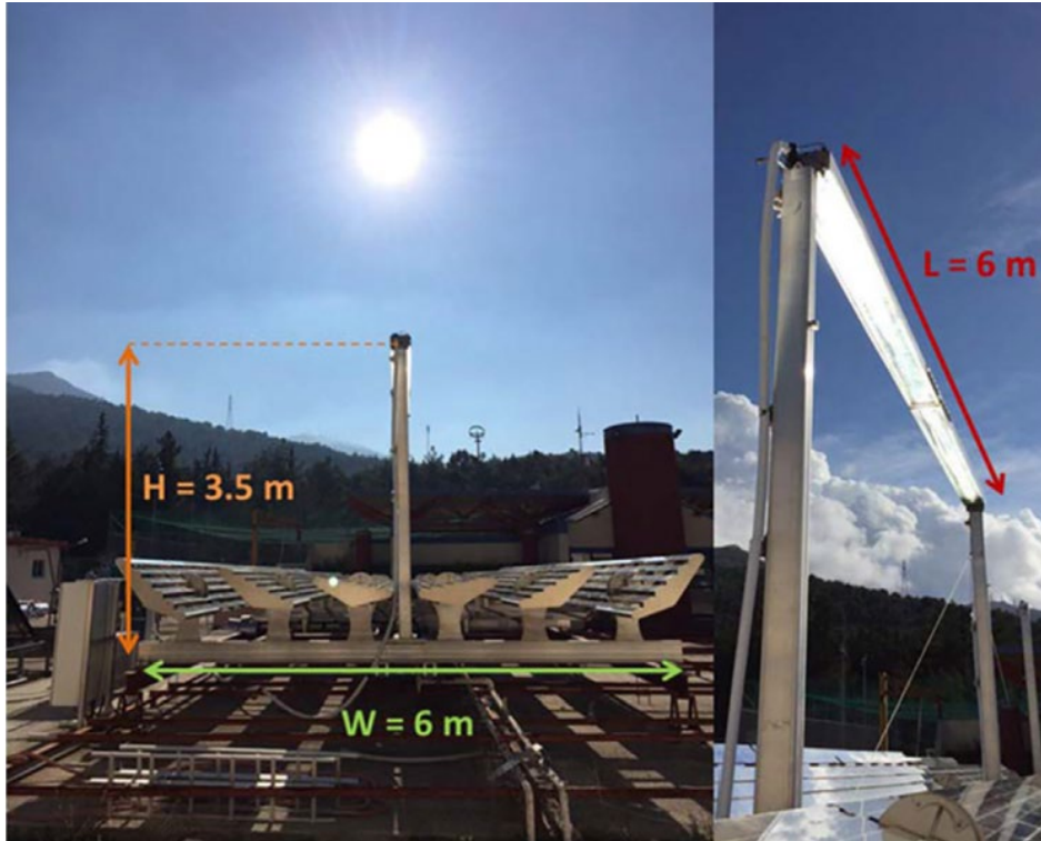
Figura 2. 16 - Coletor solar linear Fresnel montado em Atenas, Grécia.
