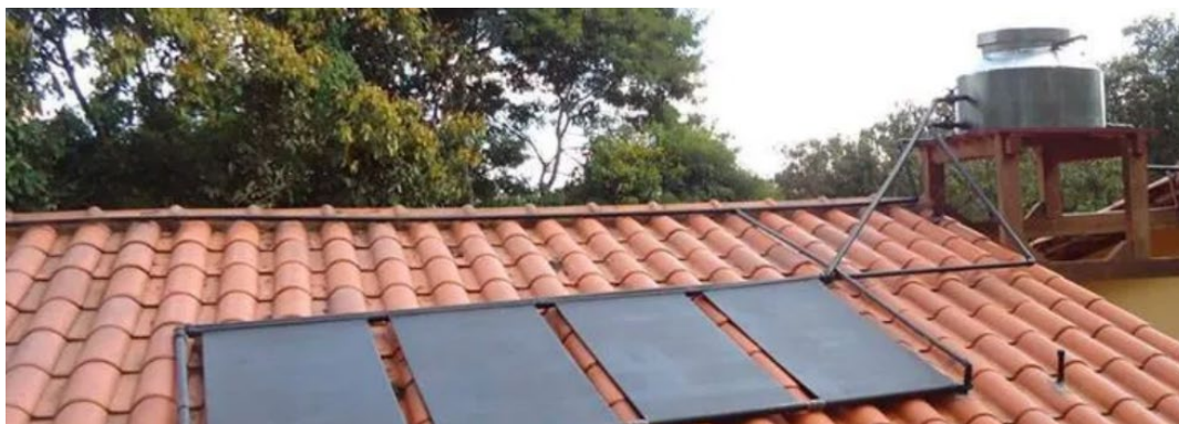
Figura 3. 3 - Coletor solar plano em aplicação residencial.
