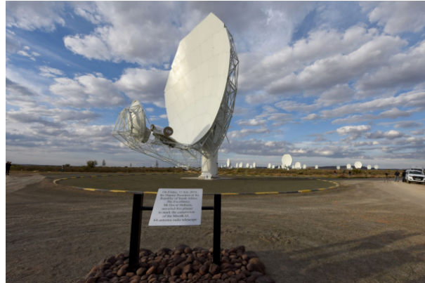
Figura 5.5: O radiotelescópio MeerKAT, um conjunto de 64 antenas de 13,5 metros [23]
