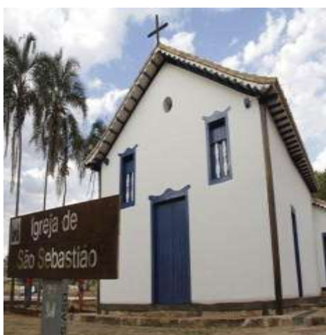
Figura 05: Igrejinha de São Sebastião.
