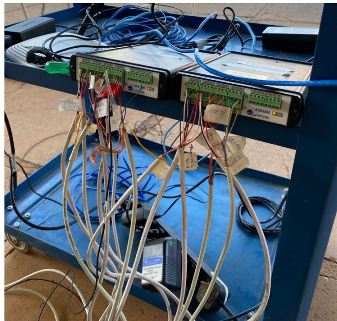
Figura 4.16: Extensômetros e transdutores conectados aos módulos e calibrados, Fonte: De autoria própria.
