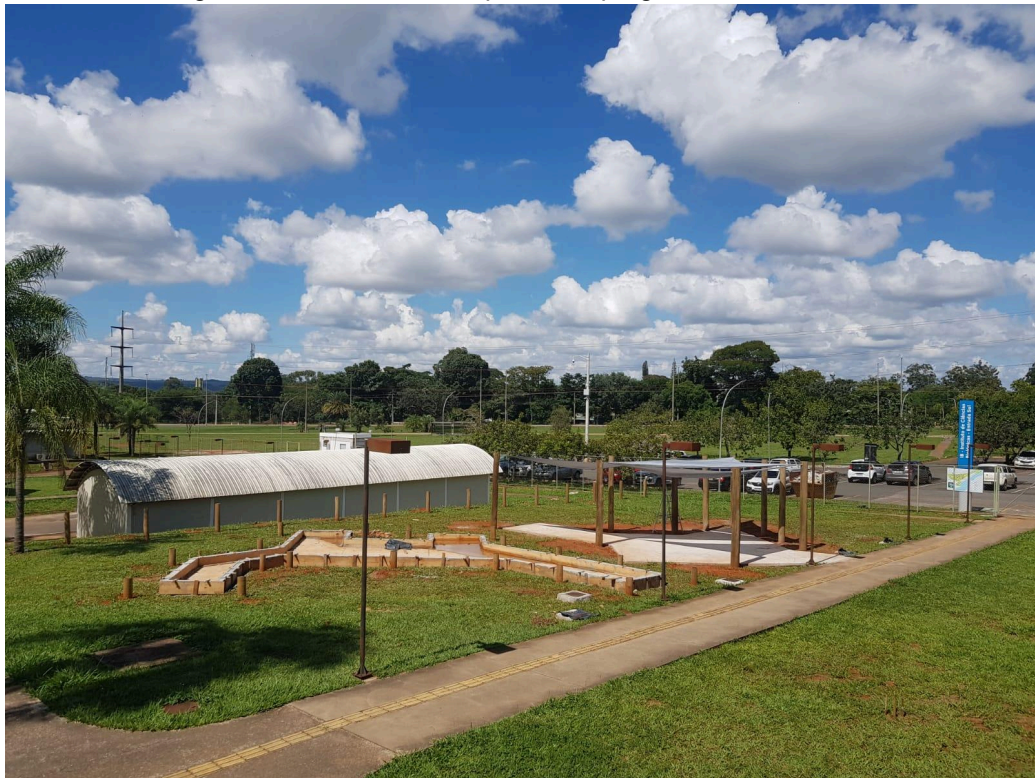
Figura 13 – Foto do contrapiso e do pergolado construídos.
