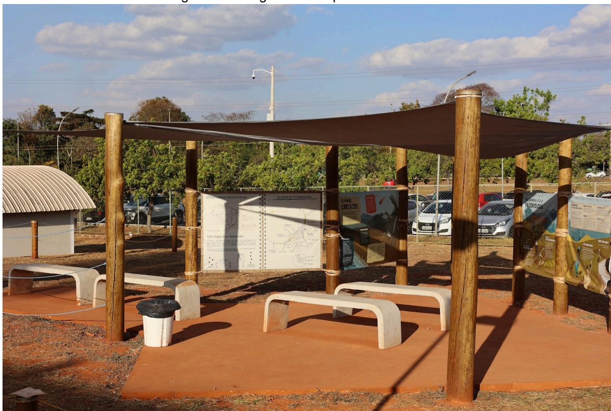
Figura 17– Pergolado com painéis instalados.
