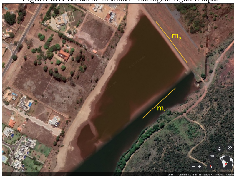
Figura 3.7. Locais de medidas - Barragem Água Limpa.
