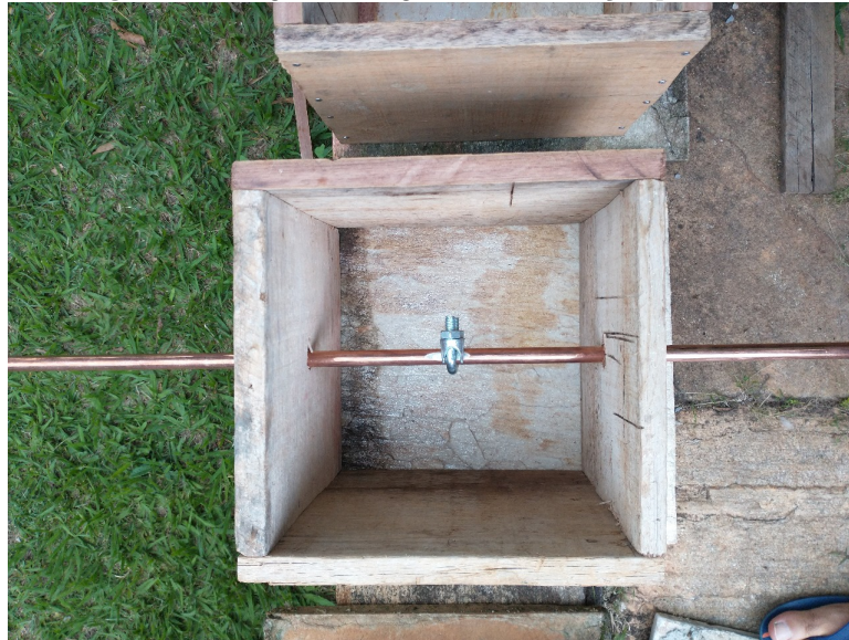
Figura 2. Registro fotográfico de execução parcial 02.
