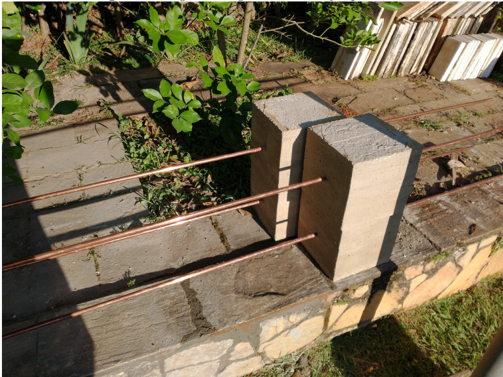
Figura 4. Registro fotográfico de execução parcial 04.
