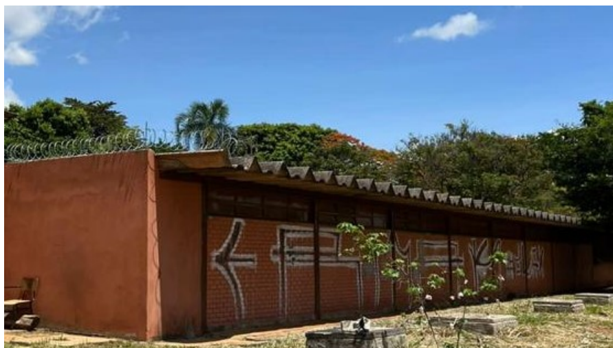
Figura 4.5: Vista lateral do Centro de Ensino Médio 02 Ceilândia.
