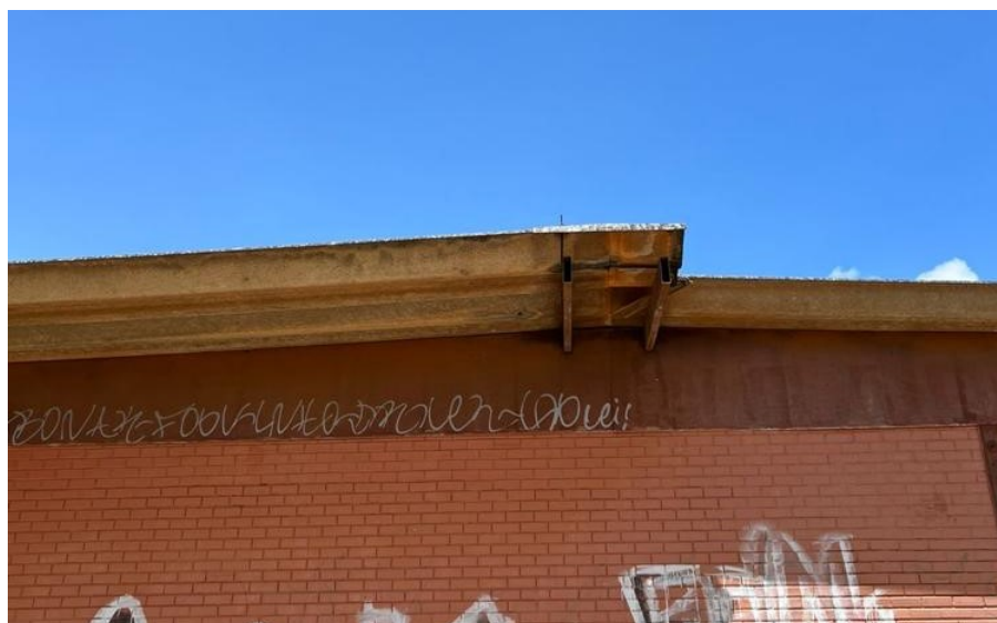
Figura 4.6: Vista aproximada do telhado do Centro de Ensino Médio 02 Ceilândia.
