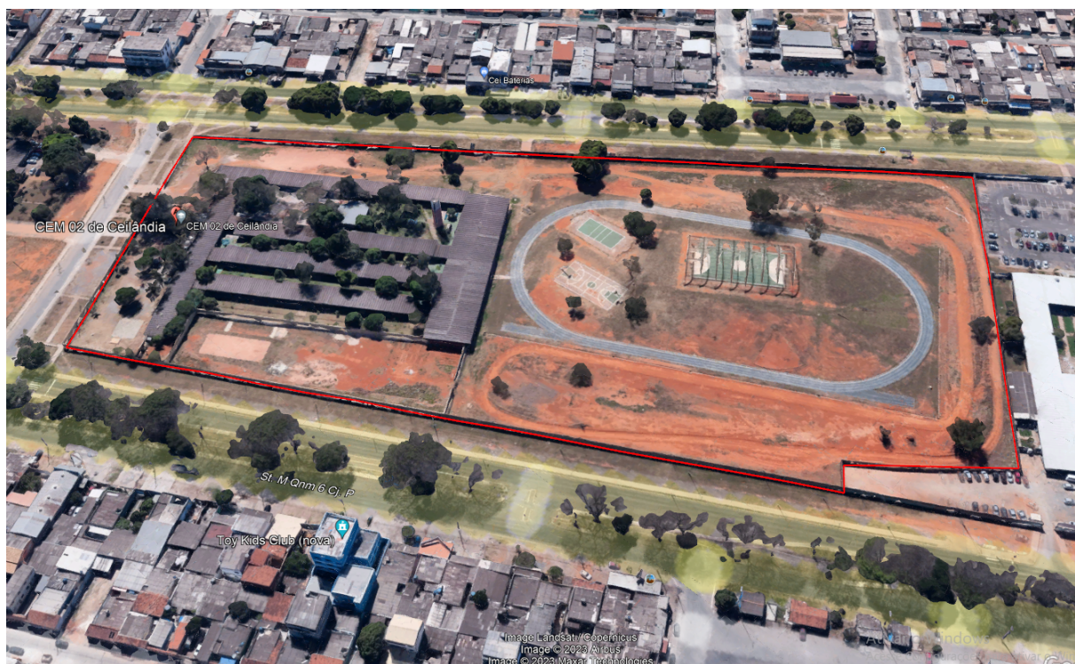
Figura 3.1: Vista aérea Centro de Ensino Médio 02 Ceilândia - Distrito Federal.
