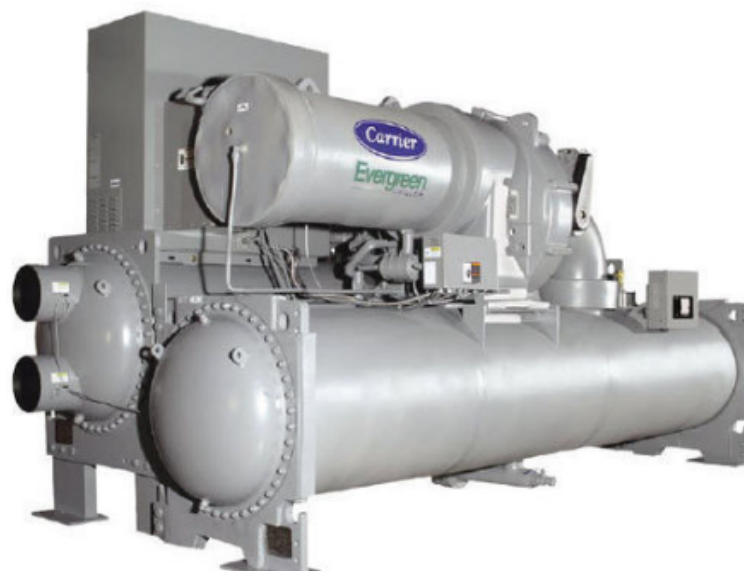
Figura 2.7 – Chiller de um sistema CAG de condensação a água (MALATHI, 2018)
