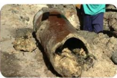
Figura 2. Tubulação de rede de esgoto obstruída com blocos rígidos por emulsificação de óleo, restos de comida e outros objetos.
