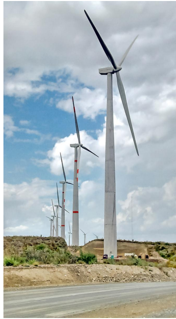
Figura 11: Torre de Concreto.
