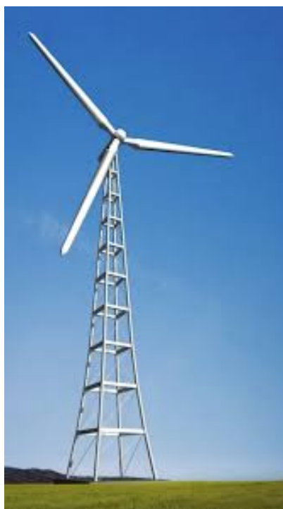
Figura 9: Torre Treliçada pré-fabricada.
