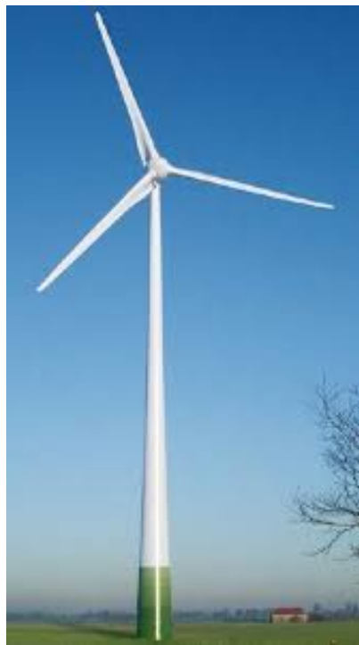
Figura 8: Torre de aço tubular.
