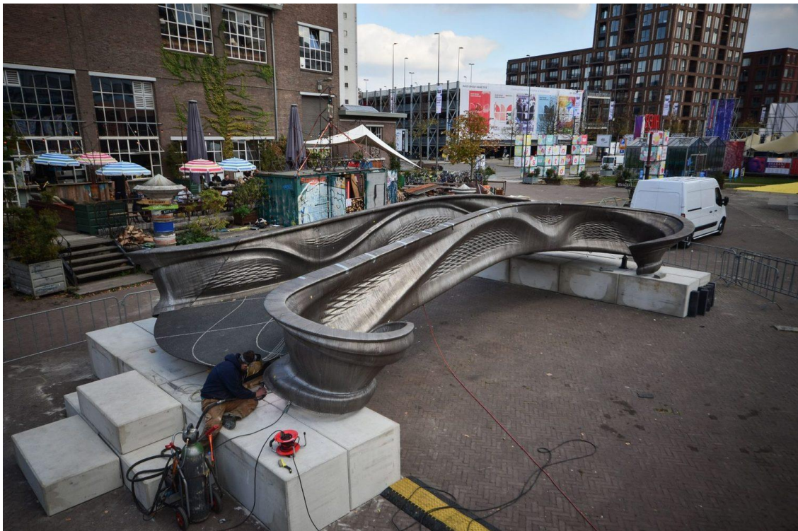
Figura 1 Ponte de aço inoxidável produzida completamente por manufatura aditiva (MX3D, 2020)
