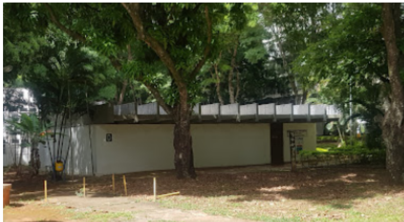
Figura 1 – Área externa da Biblioteca Infantil 104/304 Sul.
