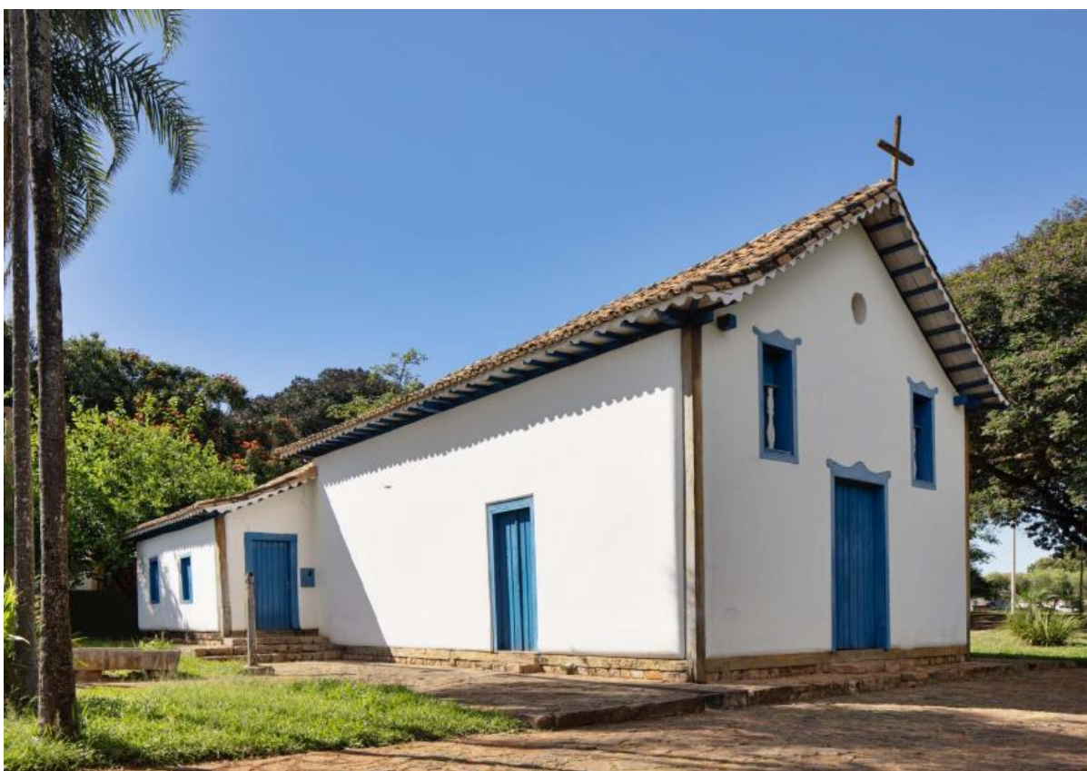
Figura 3 - Igrejinha Velha de São Sebastião (2022)
