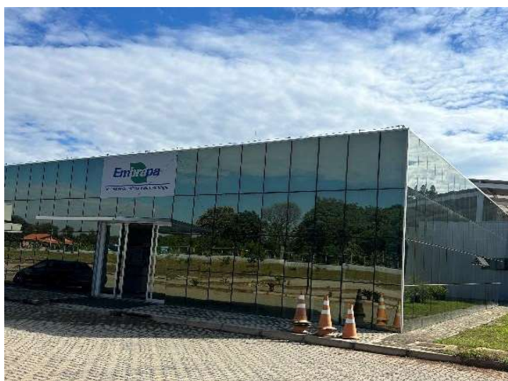
Figura 2. Prédio da Estação de Quarentena de Germoplasma Vegetal, localizado na Embrapa Recursos Genéticos e Biotecnologia, Brasília, DF. Fonte: Mayara Siqueira Messias
