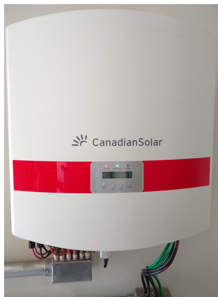
(a) Imagem fotográfica do Inversor CSI-50KTL-GI.
