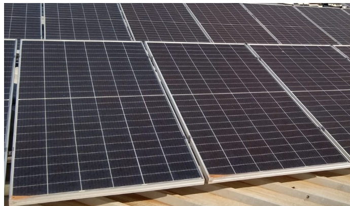
(c) Módulos 6 e 7 da fileira 3 com sujeira uniforme por sua superfície.
