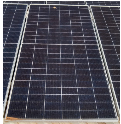
(b) Módulo 6 da fileira 2 com sujeira pontual.
