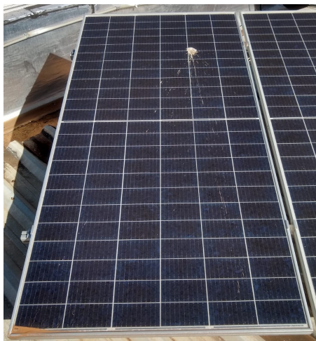
(a) Módulo 4 da fileira 1 com sujeira pontual.
