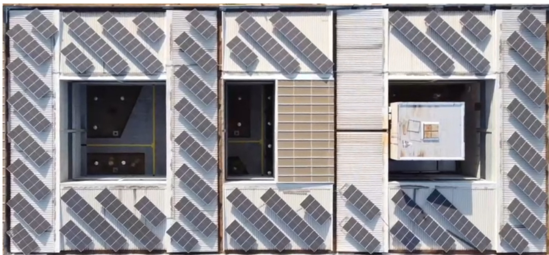
Figura 16 – Instalação dos Módulos no Prédio UED.
