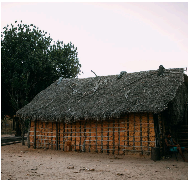
[Foto 14: casa tradicional Krahô. Assim são construídas as casas: parede de barro sustentado por madeiras e teto da trama de palha de buriti. Paulo me conta que atualmente já estão sendo construídas casas de tijolo e telha na aldeia, mas que essas casas são mais quentes, a casa tradicional era melhor por ser mais fresca.]
