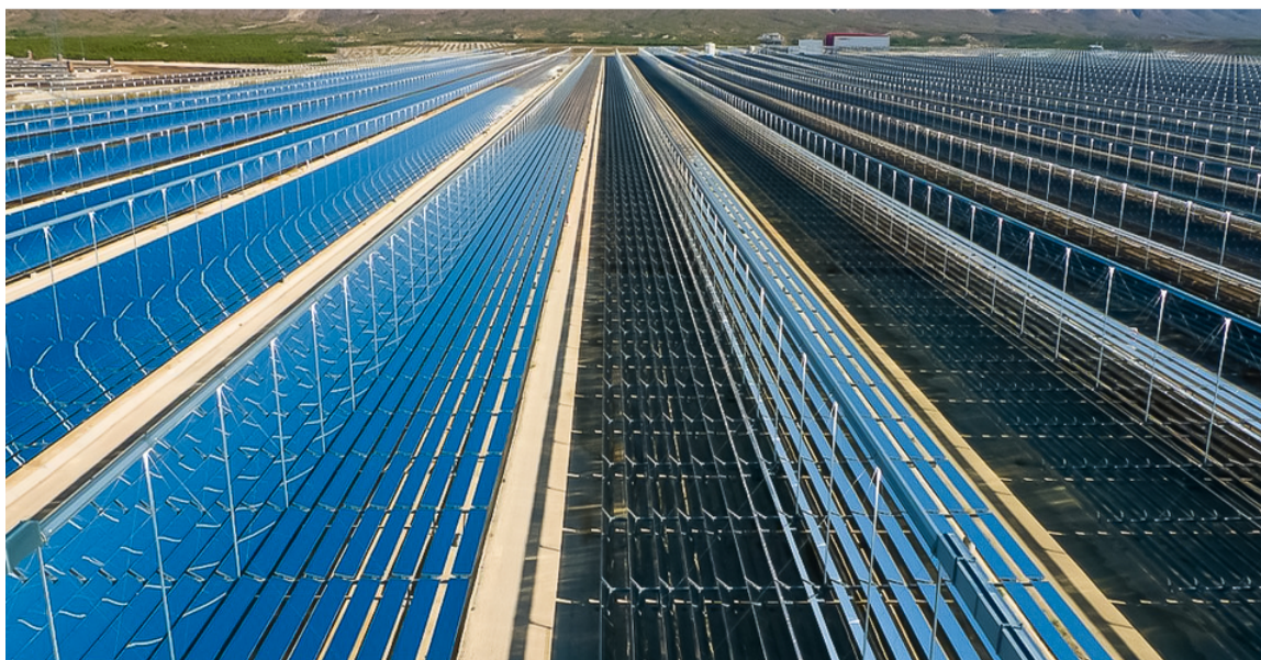
Figura 5: Usina Puerto Errado, na Espanha (TSK, 2023).
