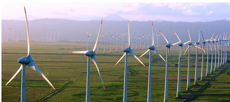
Figura 2.15: Um parque eólico On-shore (Fonte: https://www.iberdrola.com )
