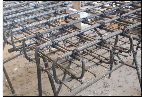
Figura 3.7 – Detalhe da disposição dos ganchos nas bordas da laje.
