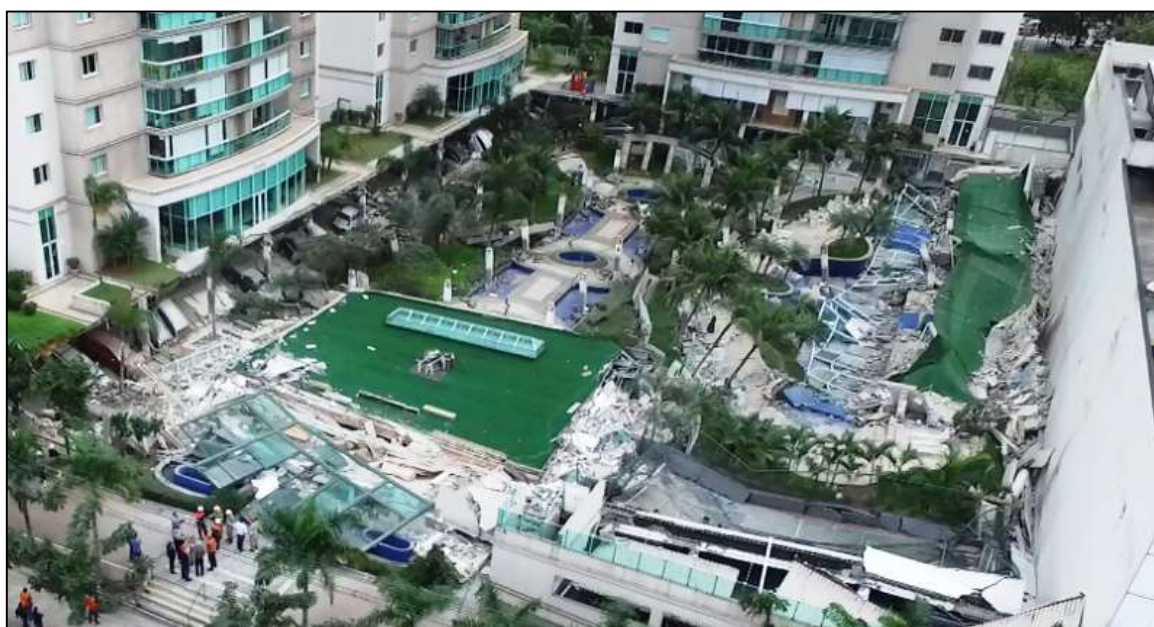
Figura 1.1.2 – Colapso de laje lisa por punção no condomínio Grand Parc, Vitória (2016). Fonte: < https://www.folhavoria.com.br/geral/noticia/07/2018/desabamento-do-grand-parc-completa-2-anos-e-moradores-devem-voltar-para-casa-so-em-2019 >
