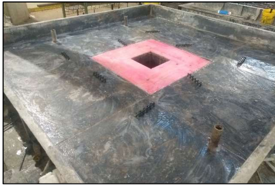
a) Fôrma preparada com desmoldante
