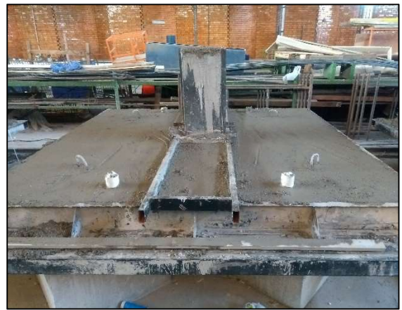
d) Laje concretada
