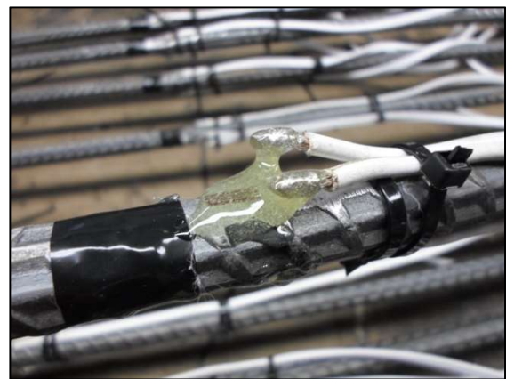
(iv) Proteção com resina epóxi;
