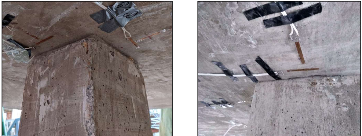
Figura 3.28 – Extensômetros fixados no concreto.
