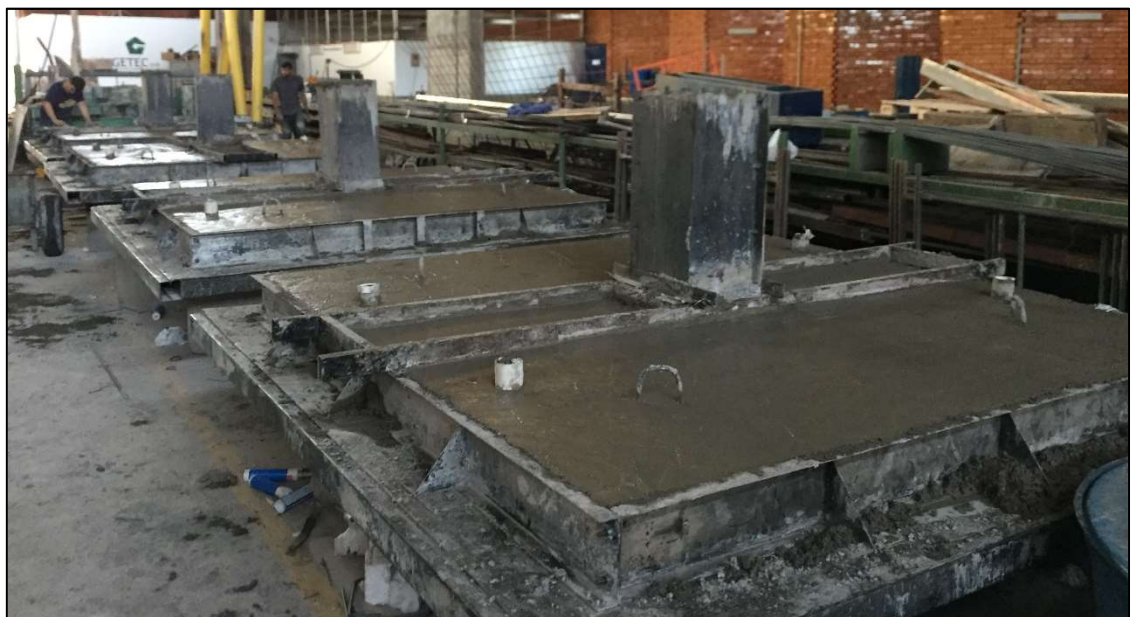
e) Todas as lajes concretadas
