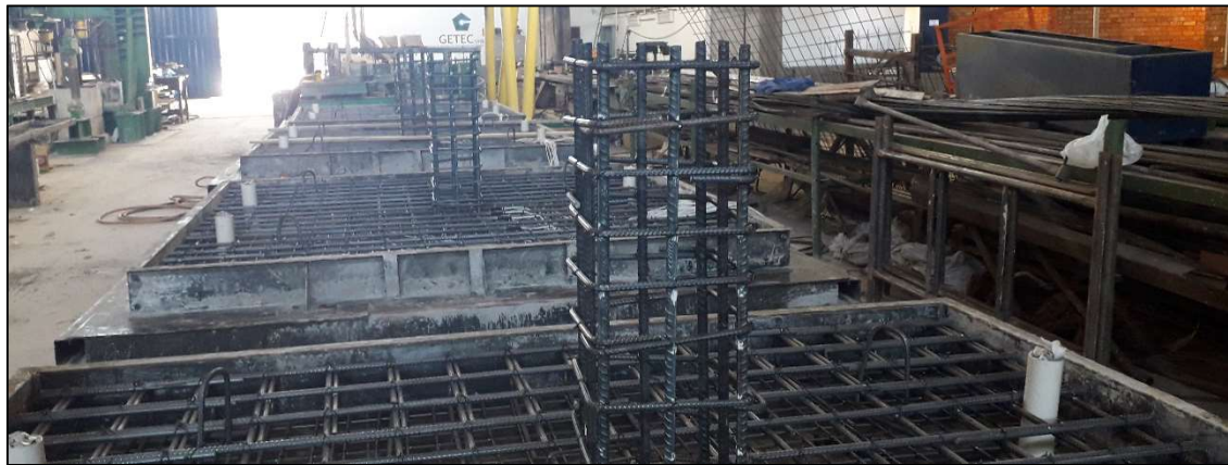
c) Armaduras posicionadas para a concretagem.
