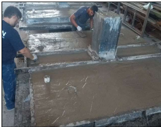
c) Acabamento na superfície da laje
