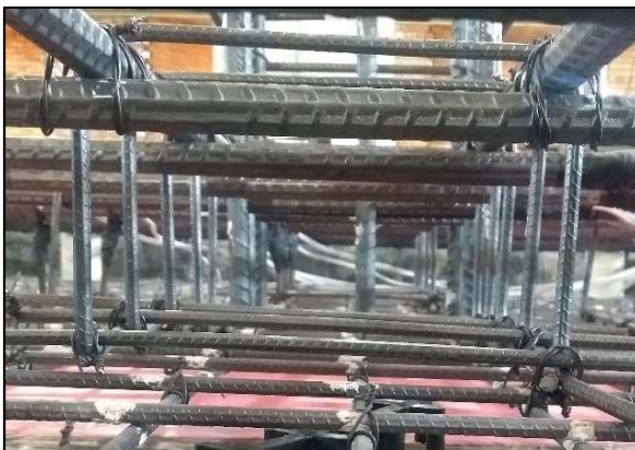
Figura 3.18 – Detalhe do estribo “caranguejo” na laje CTA.
