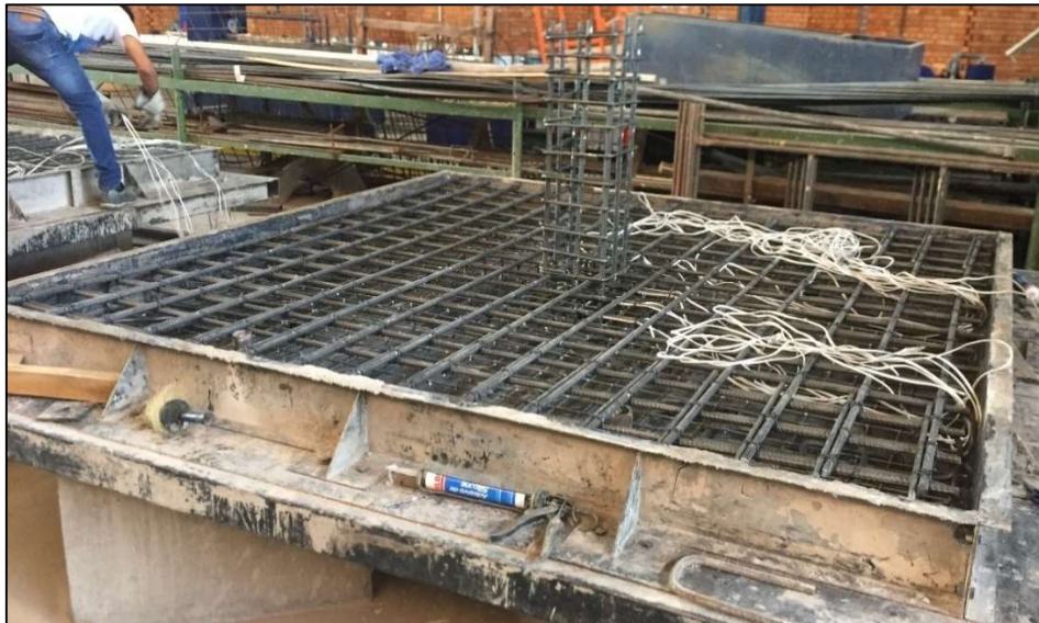
Figura 3.8 – Armadura de flexão montada no laboratório.
