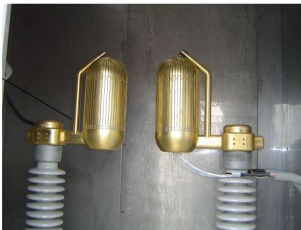
Figura 2.10: GAP protegendo o banco de capacitores e o MOV.
