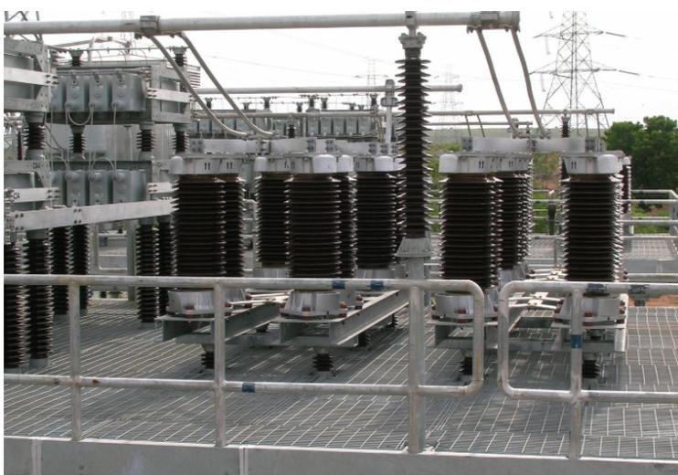
Figura 2.9: Coluna de MOV protegendo um banco de capacitor série (ARRESTERWORKS, 2008).
