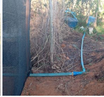
Foto 65: Montagem do sistema de irrigação.
