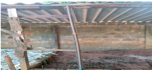
Foto 18: Colocação dos bebedouros.
