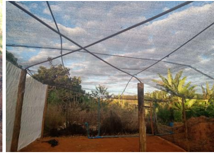
Foto 66: Sistema de irrigação finalizado.
