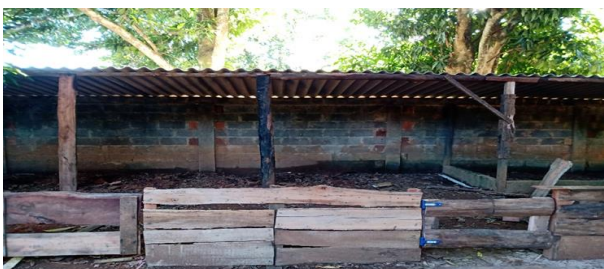
Foto 16: Fixação das telhas.
