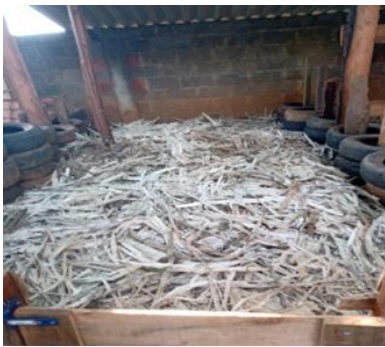
Foto 23: Colocação do bagaço da cana de açúcar.
