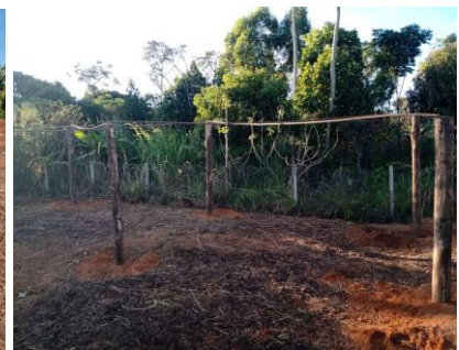
Foto 60: Colocação dos troncos.
