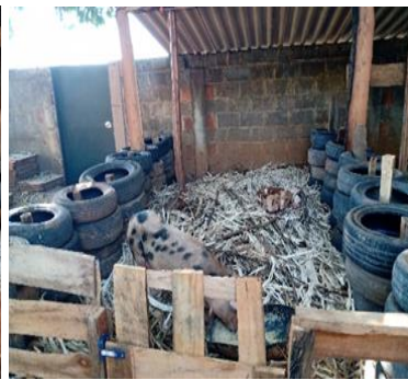
Foto 24: Testando a baia finalizada.
