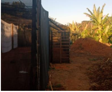
Foto 64: Construção da porta.
