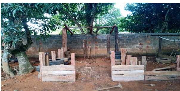
Foto 14: Colocação das tábuas.
