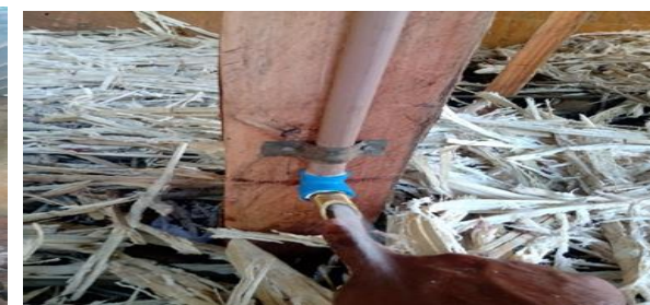
Foto 19: Colocação dos bicos.
