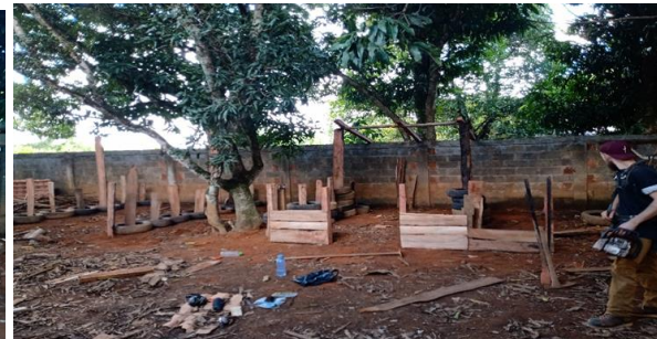
Foto 15: Construção das baias.
