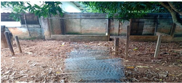
Foto 10: Retirada de cerca para reaproveitamento do espaço.
