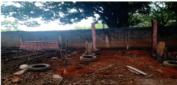
Foto 12: Buracos cavados para colocação das madeiras.
