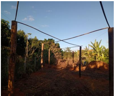
Foto 61: Ferros colocados em "x" para cobertura.
