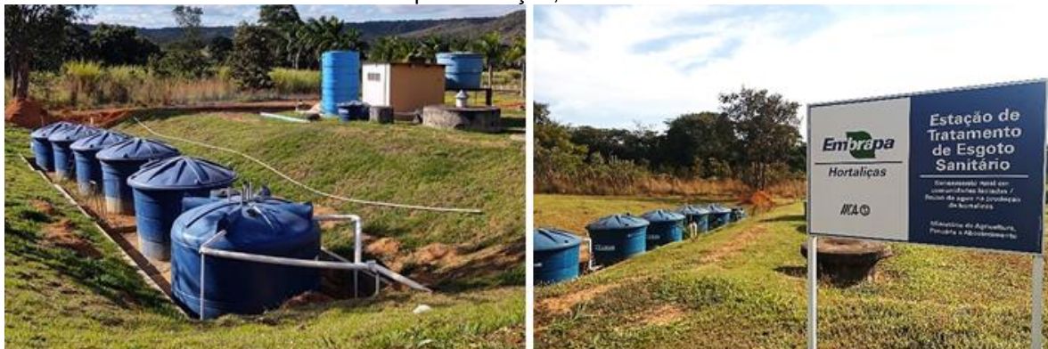
Figura 26: Protótipo do Sistema ReAqua funcionando em condições operacionais (TRL/MRL 7) na Embrapa Hortaliças, Brasília – DF.
