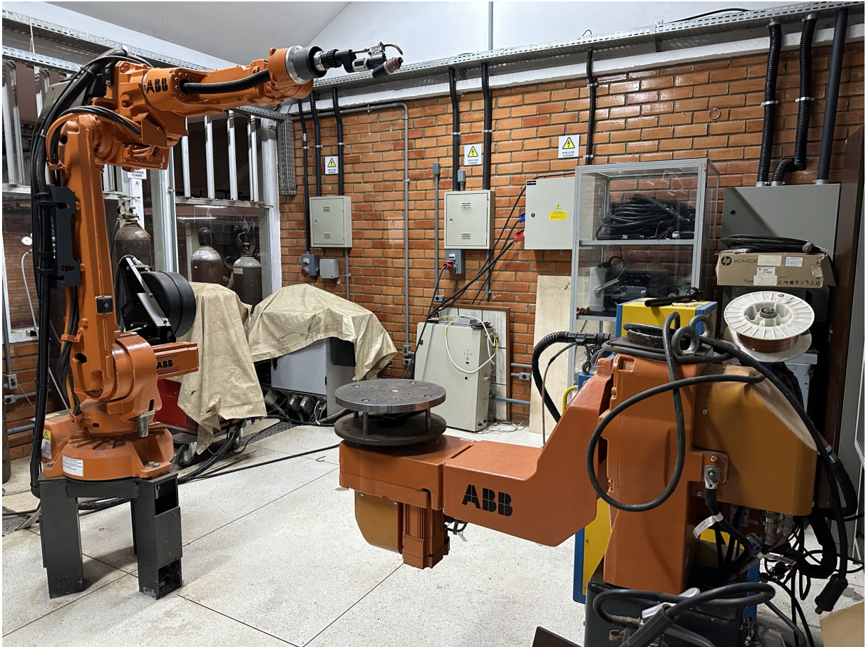
Figura 4.10 – Célula de manufatura aditiva instalada no laboratório GRACO da UnB, composta pelo robô ABB IRB 2600 e mesa posicionadora robótica ABB IRBP A250.
