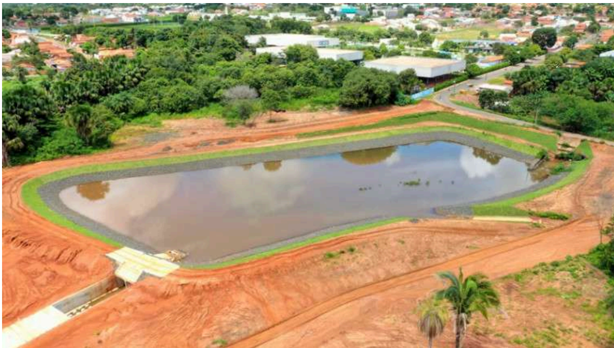
Figura 5 - Bacia de detenção.
