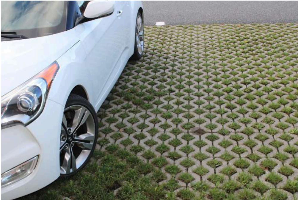
Figura 7 - Pavimentos permeáveis e áreas de infiltração.
