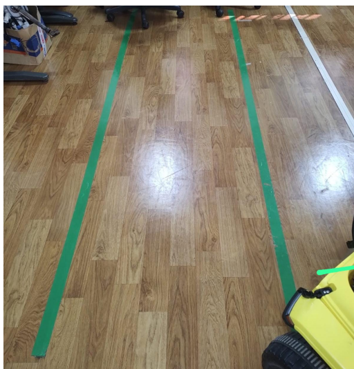
Figura 28 – Faixas de rodagem instaladas no ambiente de desenvolvimento
