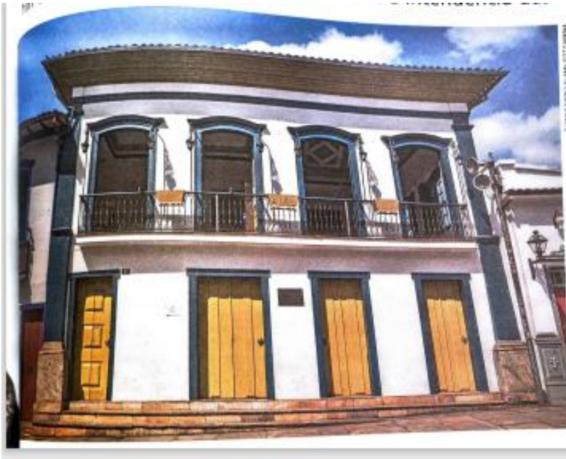
Antiga casa de intendência, construída no início do século XVIII. Atualmente, funciona a Casa de Cultura de Mariana (MG). Fotografia de 2015.
