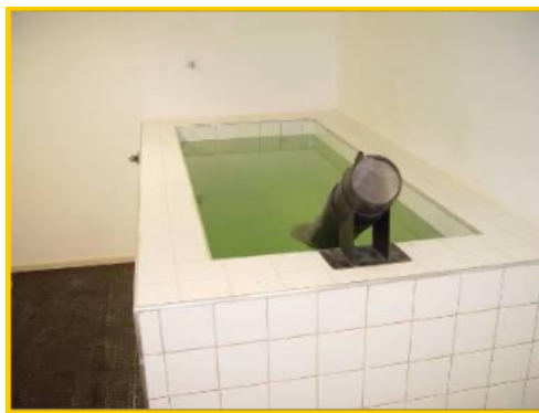
(a) Exemplo 1 - Tanque de Água
