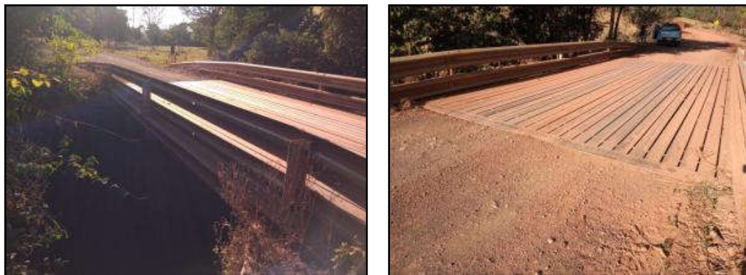
Figura 11. Substituição da estrutura de madeira da ponte do Córrego Pedreiras. (Data: 17/06/2021)
