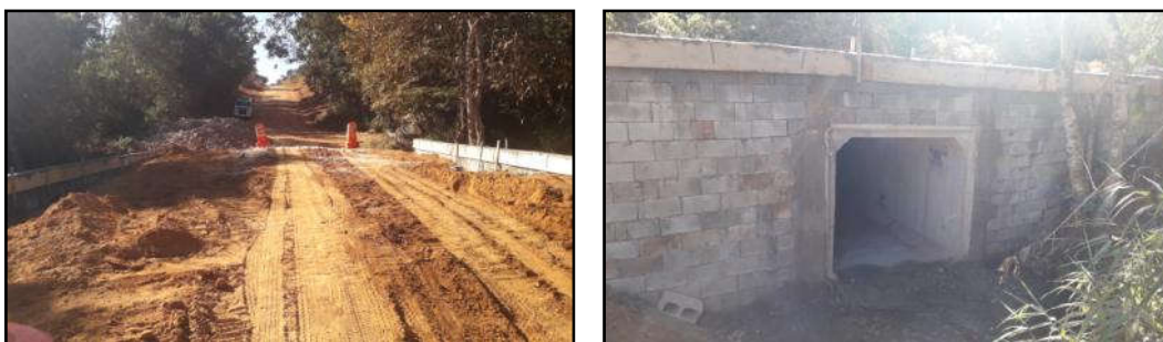
Figura 12. Obras de construção de galeria de drenagem do Córrego Quinze. (Data: 28/06/2023)
