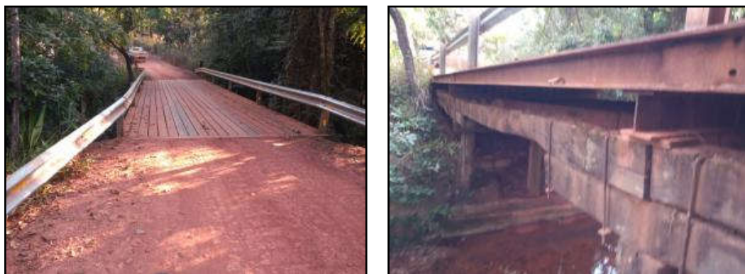
Figura 10. Substituição do tabuleiro de madeira da ponte do Córrego do Ouro. (Data: 17/06/2021)
