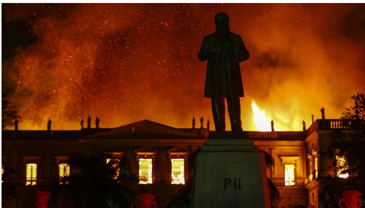
Figura 03 – Incêndio no Museu Nacional
