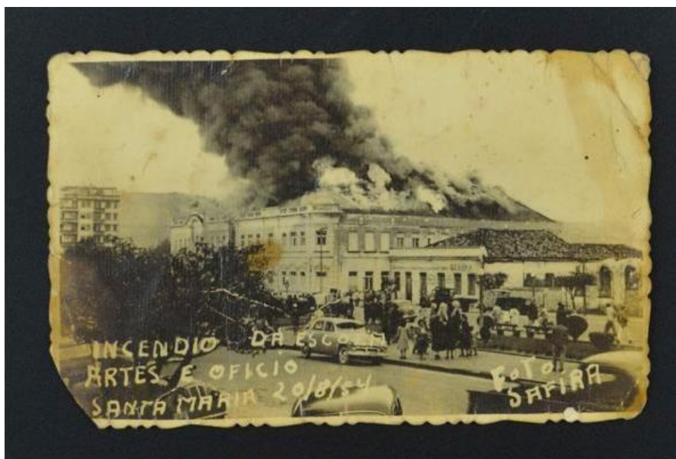
Figura 00 – incêndio da Escola de Artes e Ofícios Hugo Taylor
