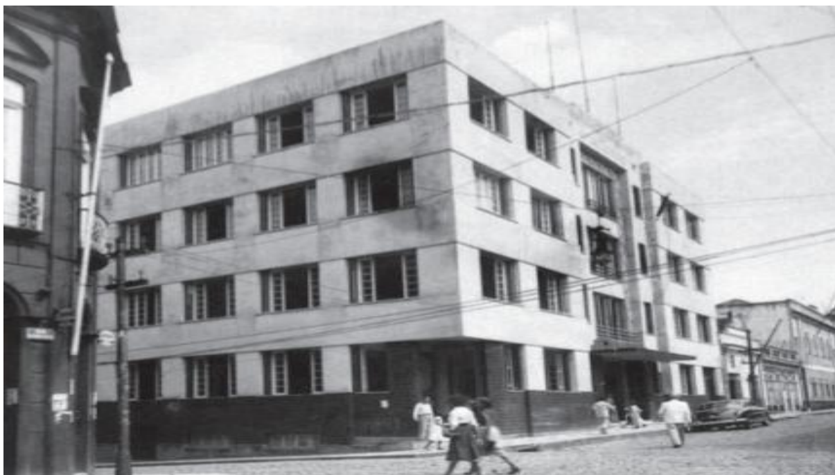
Figura 09 – Vista do edifício da Associação Comercial do Amazonas - ACA
