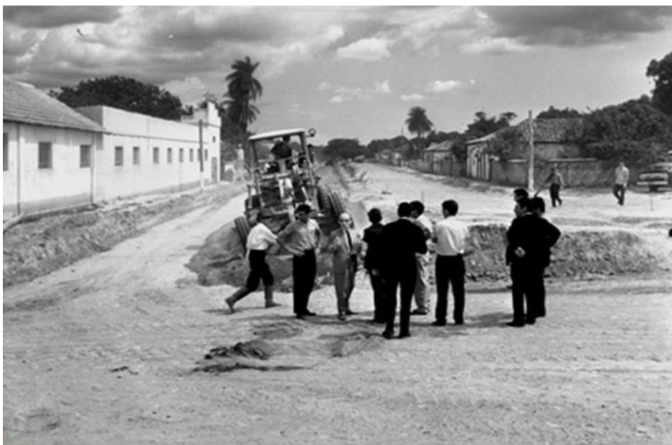
Figura 3 - Obras de pavimentação da Avenida Cel. Salvador Coelho, 1963
