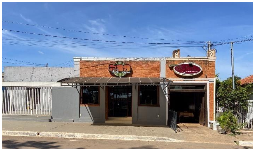
Figura 51 - Prédio do 389 Burguer e Pepe Nero após a reforma.
