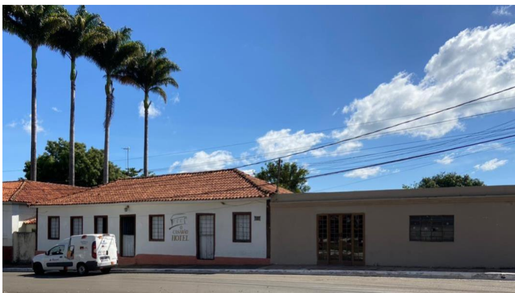
Figura 34 - O Casarão hotel e anexo, 2023
