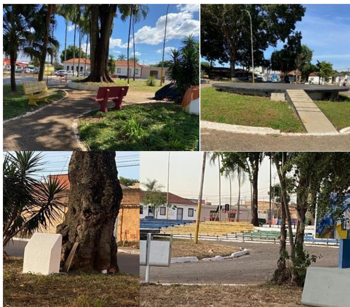
Figura 62 - Indícios de má conservação e intervenções sem autorização.
