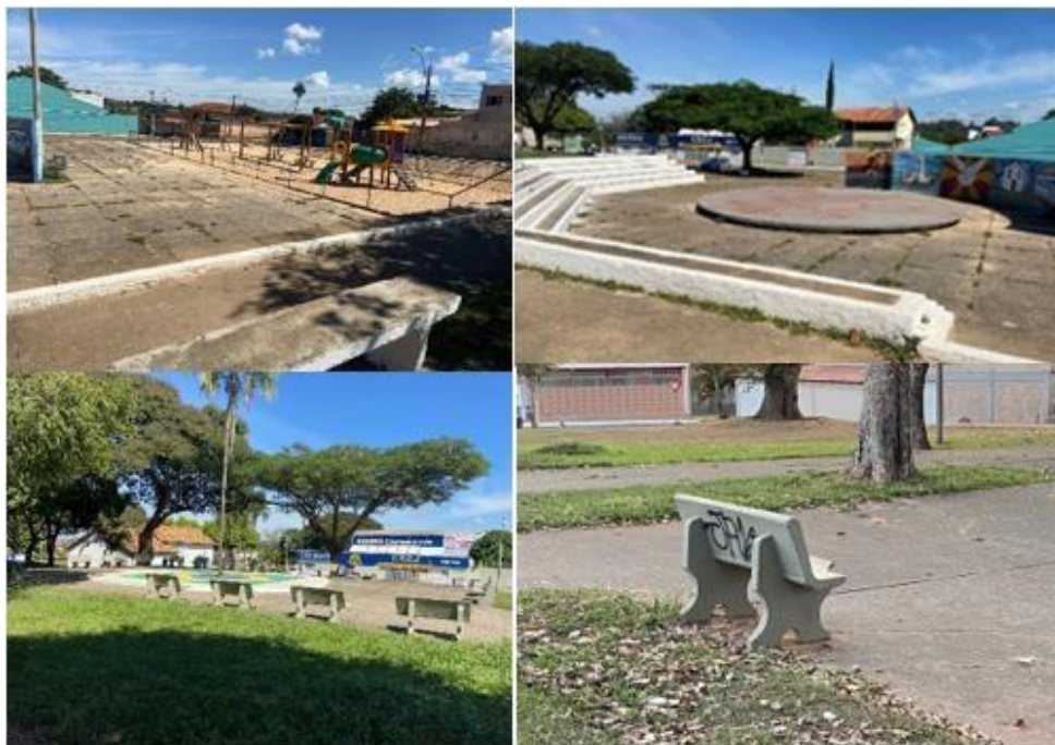
Figura 53 - Indícios de depredação da Praça São Sebastião.
