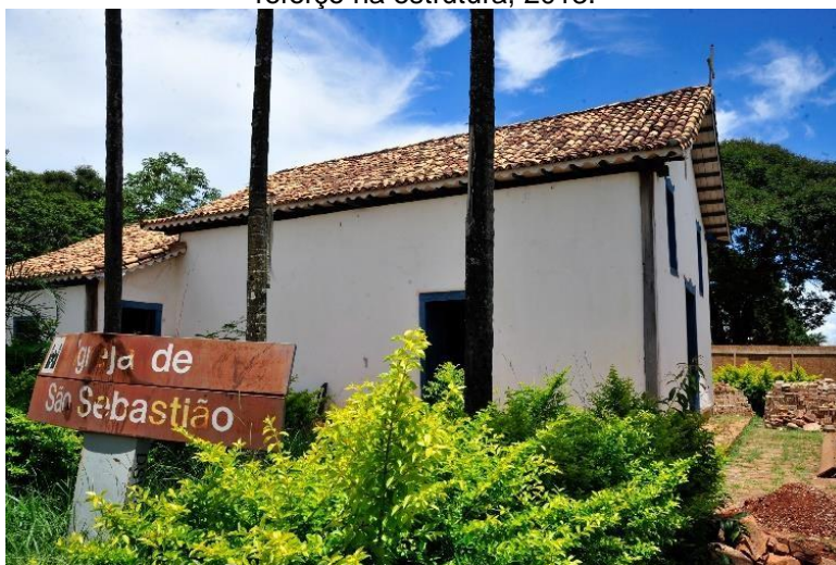
Figura 10 - Igreja de São Sebastião, em Planaltina (DF), passa por obras de restauração e reforço na estrutura, 2013.
