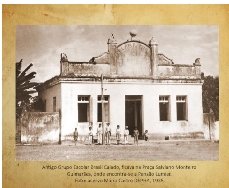
Figura 46 - Segundo prédio que abrigou o Colégio Brasil Caiado, 1935.
