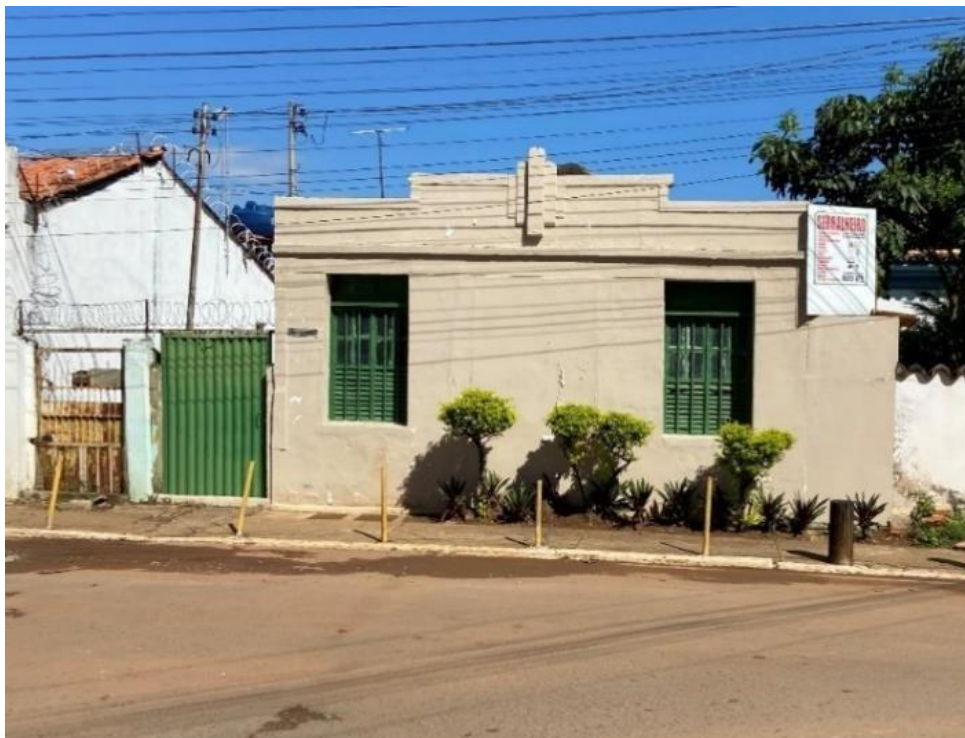
Figura 30 - Residência que era a antiga farmácia, 2023.
