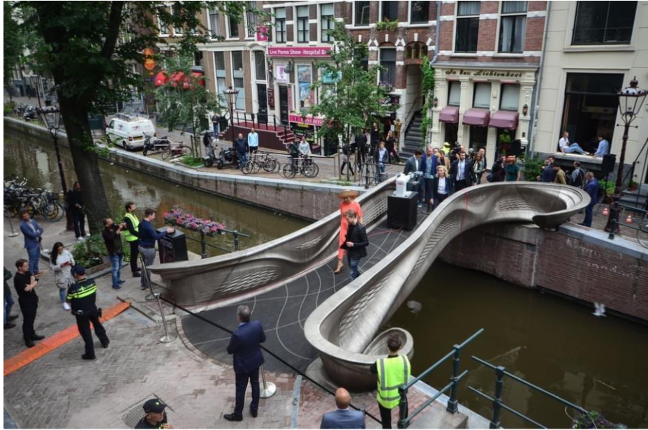
Figura 4 – Ponte feita por manufatura aditiva. (MX3D, 2023).
