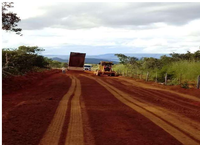
Figura 3 – Estrada Interna do aterro
