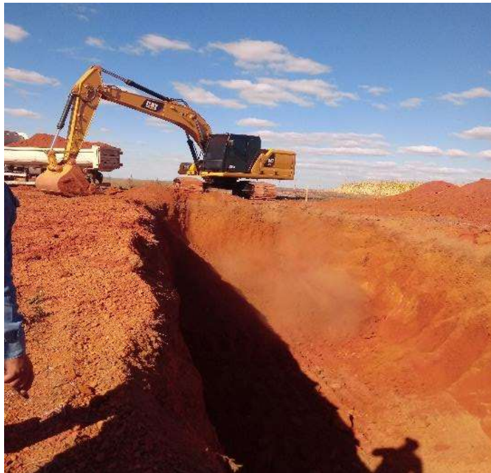
Figura 1 – Abertura de vala do aterro sanitário.
