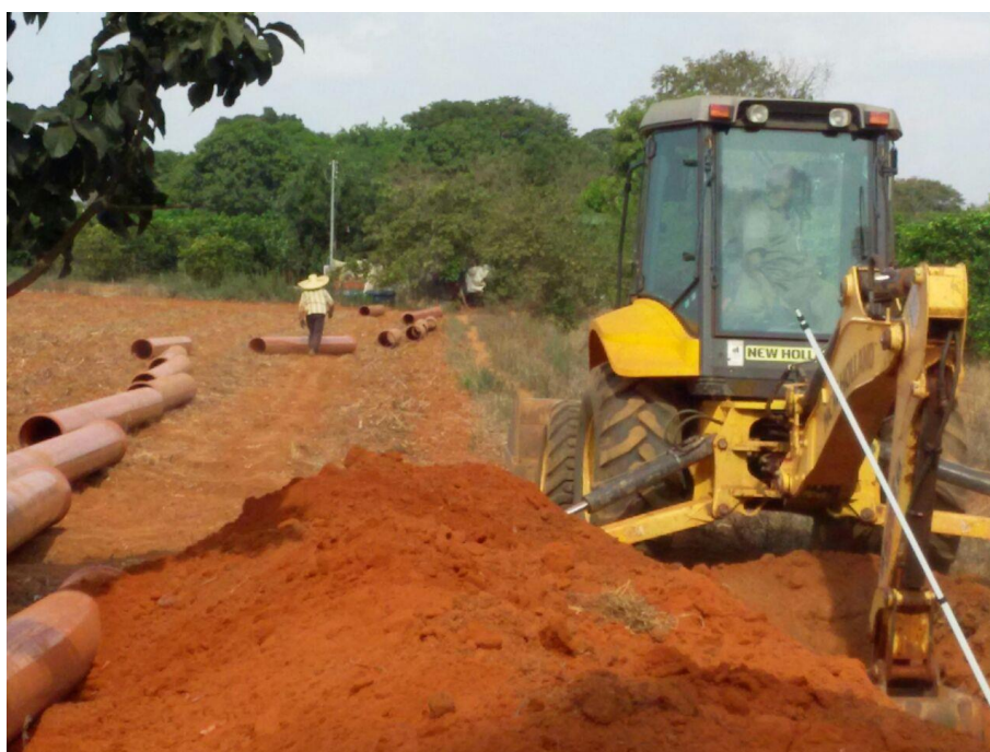
FIGURA 8 – Início das obras de revitalização do canal, no ano de 2016, com a instalação das primeiras tubulações.
