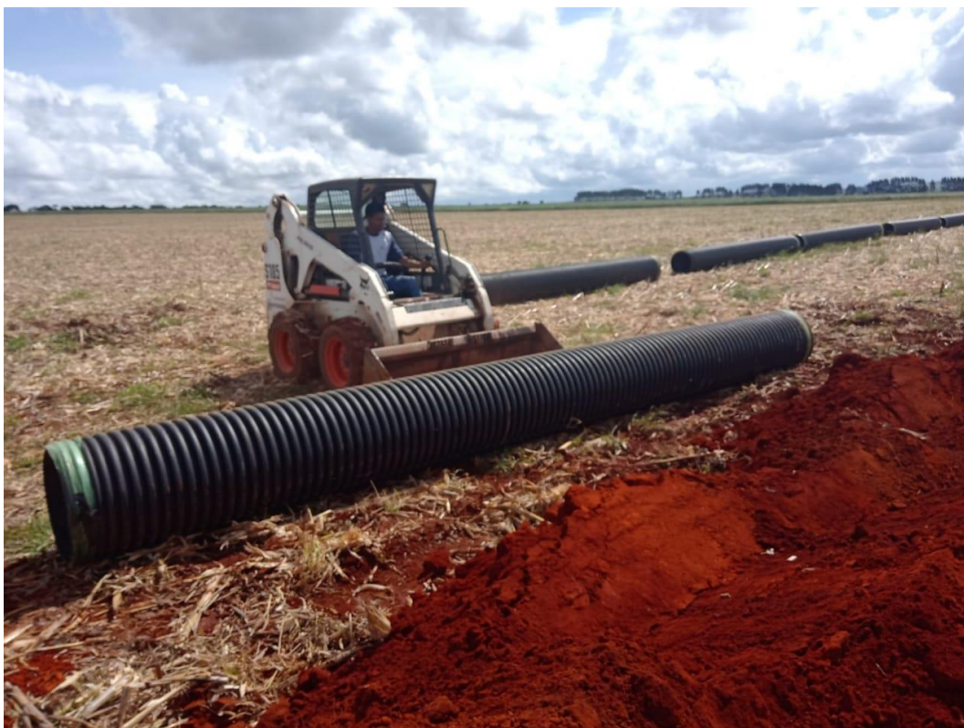
FIGURA 10 – Equipamento utilizado no carregamento das tubulações e no transporte da terra escavada.
