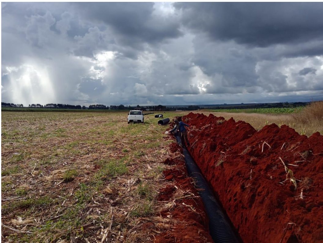
FIGURA 9 – Continuação das obras de revitalização. Neste trecho, houve a necessidade de escavar um novo leito ao lado do antigo, uma vez que a presença de água no mesmo impedia que as tubulações fossem instaladas.
