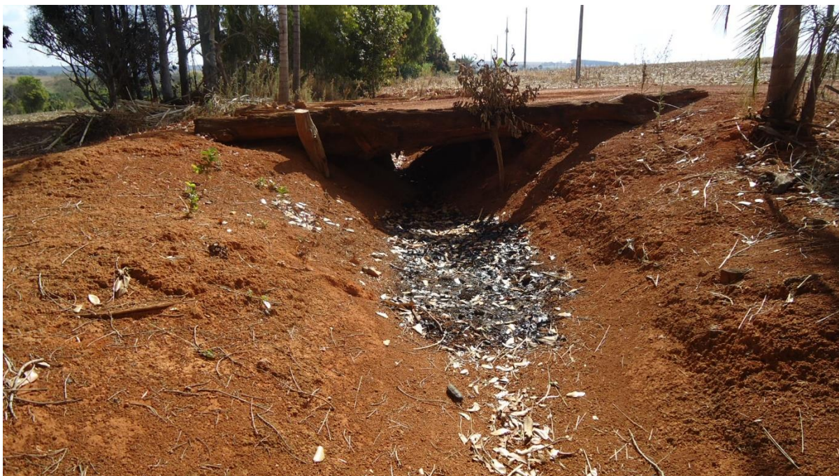
FIGURA 6 – Leito do canal já sem escoamento de água, sendo este localizado no trecho final do projeto, nas propriedades da Colônia Agrícola Estanislau.
