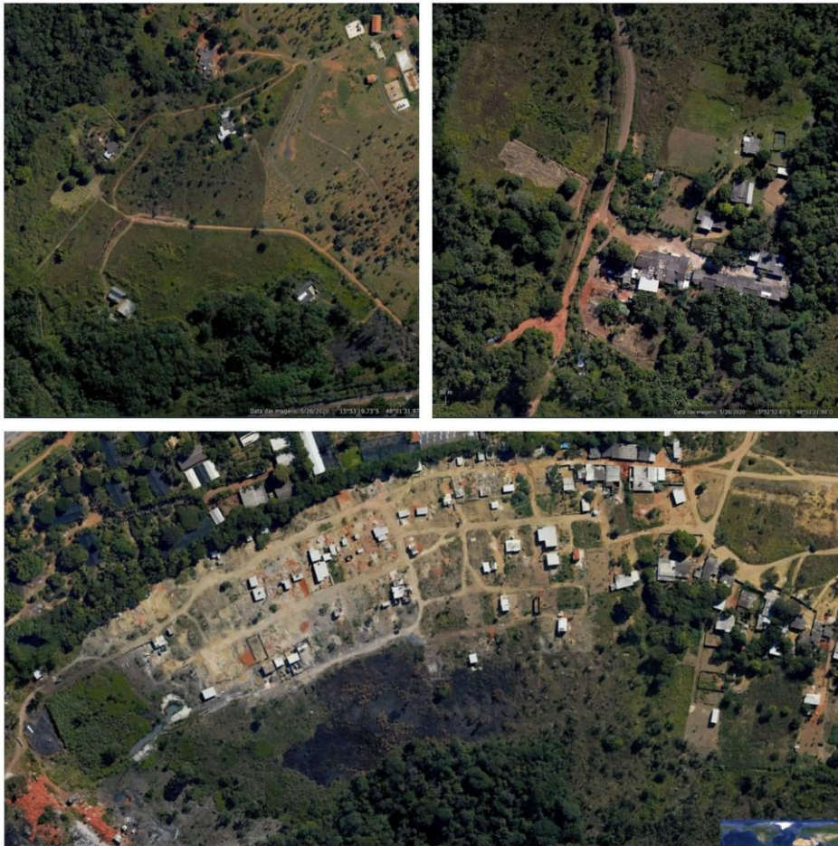
Figura 8 – Ocupações irregulares dentro do parque (Fonte: Google Earth, 2023).
