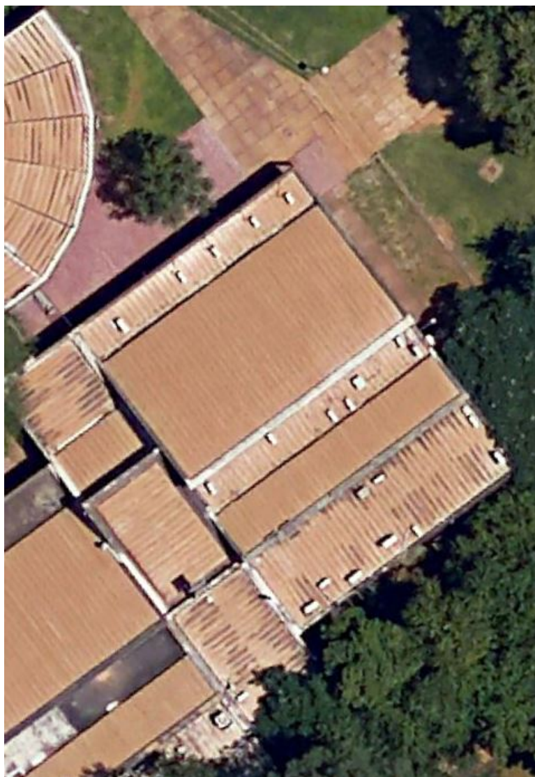
Figura 3.7: Possível local para instalação do arranjo fotovoltaico
